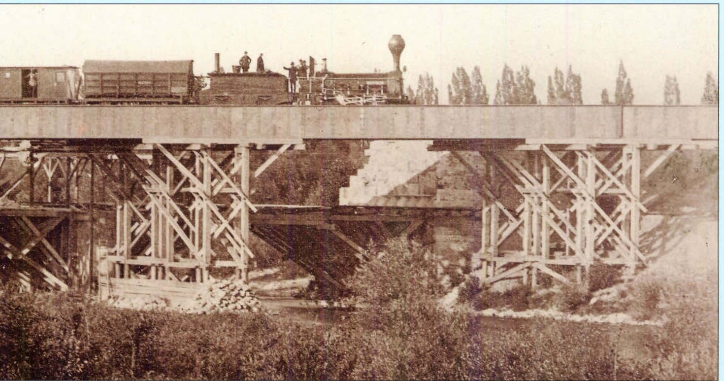
Bild 191: Im Sommer 1859 entstand dieses großartige Foto von der hölzernen Behelfsbrücke über die Wertach bei Augsburg, über die während des Baus der steinernen Bogenbrücke die Züge nach Ulm und Donauwörth fahren mußten. Abb.: Sammlung Asmus
