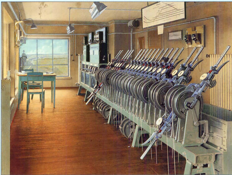
Bilder 231 bis 233: Irgendwo in Bayern: oben die Hebelbank in einem Stellwerksturm (1939), unten ein alter Schrankenwärter bei Ausübung seiner Pflicht und ganz unten ein Lätewerk zur Ankündigung von Zügen. Abb. 231: Sammlung Hufschläger, Abb. 232: Verkehrsmuseum Nürnberg, Abb. 233: Sammlung Hesselink
