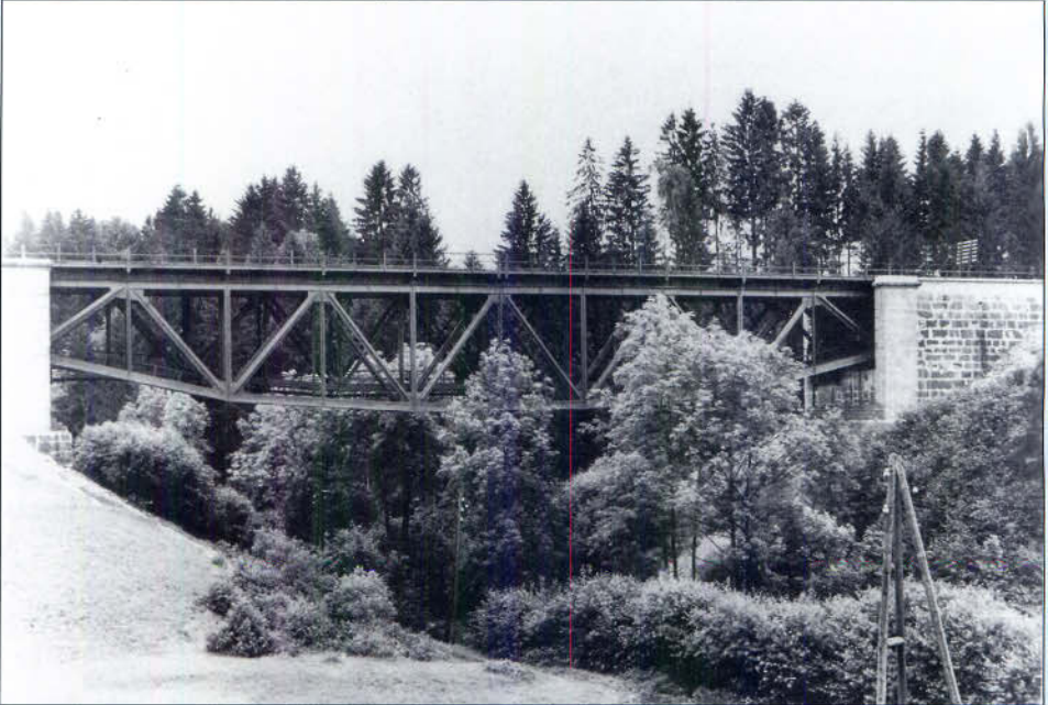
Bild 203: Die Brücke über den Waltenhofer Bach an der Süd-Nord-Bahn erhielt 1926 ihren zweiten – stählernen – Überbau. Abb. 199, 202 und 203: Sammlung Dr. Pottgießer
