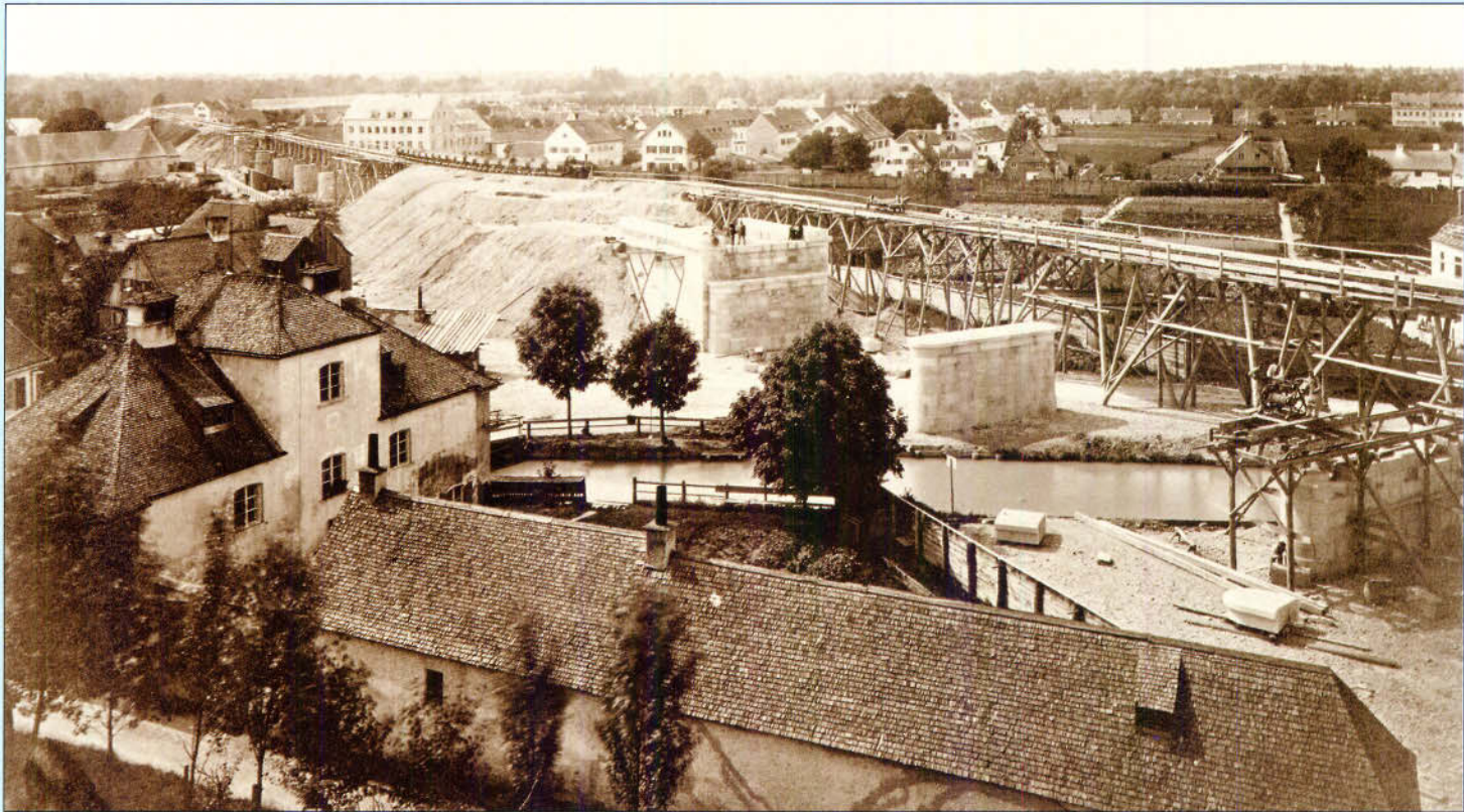
Bild 210: Die Metropole wächst und mit ihr das Eisenbahnnetz: Brückenbau über den Auer Mühlbach in Untergiesing an der Strecke München – Giesing – Aying im Jahre 1904. Abb.: Verkehrsmuseum Nürnberg
