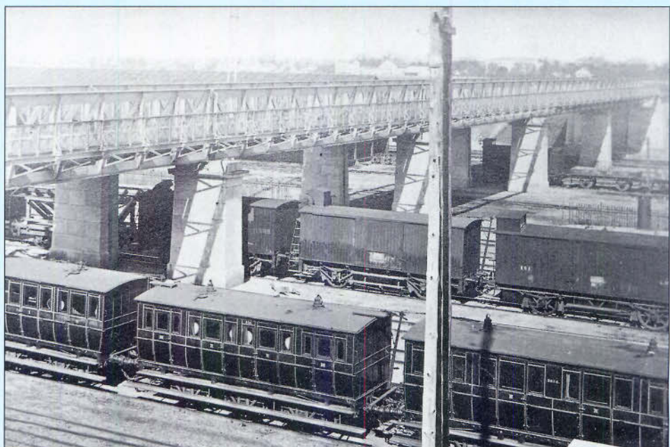
Bild 211: Auch bei weniger belasteten Konstruktionen wurde nicht gespart. Man beachte die kräftigen Pfeiler dieser Straßenbrücke über den Münchner Güterbahnhof. Abb. 208 u. 211: Sammlung Asmus
