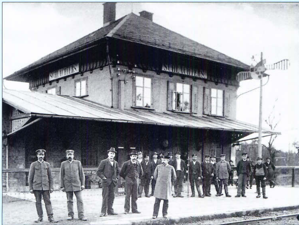
Bilder 181 und 182: Von der Klassifizierung der Stationen zur Normung der Stationsbauten war es nur noch ein kleiner Schritt. Der Gebäudetyp unten war vorgesehen für Stationen der Kategorie V (rechts) bzw. VI. Abb.: Verkehrsmuseum Nürnberg
