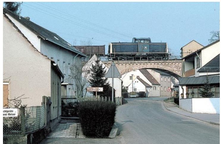
Die Bogenbrücke in Rieden stellte auf der sonst ebenen Strecke den aufwändigsten Kunstbau dar. Lokomotive 211 191 passiert am 14. April 1982 das Bauwerk in Richtung Amberg.
