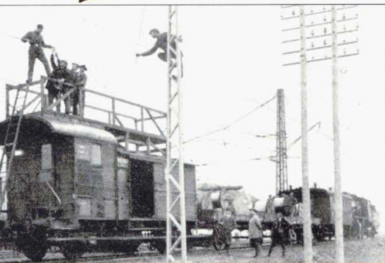
Bild 2: Dieser Pwg (pr 92 c ) erhielt eine hölzerne Arbeitsbühne und wurde als Behelfs-Turmwagen in den zwanziger Jahren im Raum München zu Elektrifizierungsarbeiten eingesetzt.
