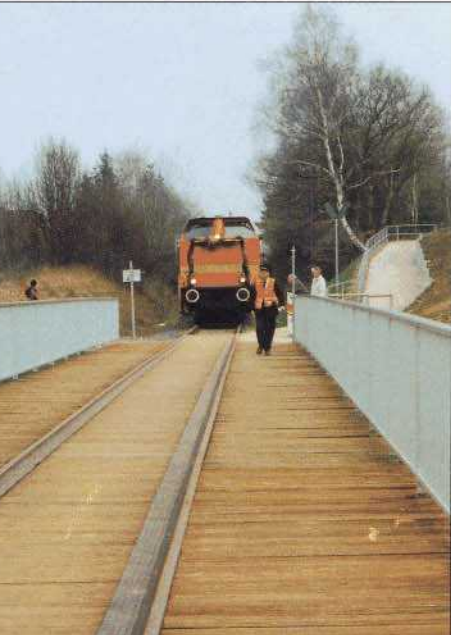
Bild 14: Diese neue Eisenbahnbrücke bei Taunusstein wurde für Radfahrer mit Gummi-Hohlprofilen ausgerüstet. Foto: K. Fr. Walbrach
