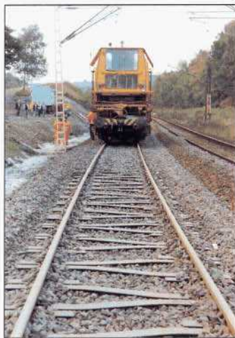
Y-Stahlschwellen im Versuchsabschnitt bei Flöha. Foto: C. Hahn
