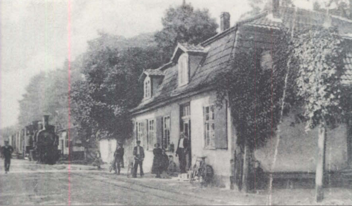
Bild 7: Die Schmalspurbahn als Straßenbahn. Gut zu erkennen sind die Gleise direkt auf dem Planum der Chaussee. Foto: Sammlung Knauf
