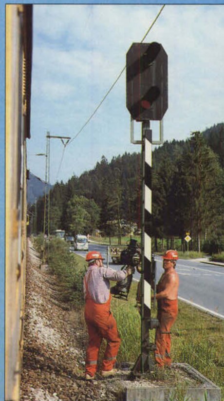
Bild 5: Auch das gelbe Dauerlicht von Überwachungssignalen für Bahnübergänge wird mit Propangas betrieben.
