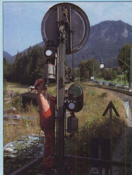
Bild 3: Propanflaschenwechsel am Vorsignal von Bischofswiesen (Strecke Freilassing – Berchtesgaden) am 14. August 1990.
