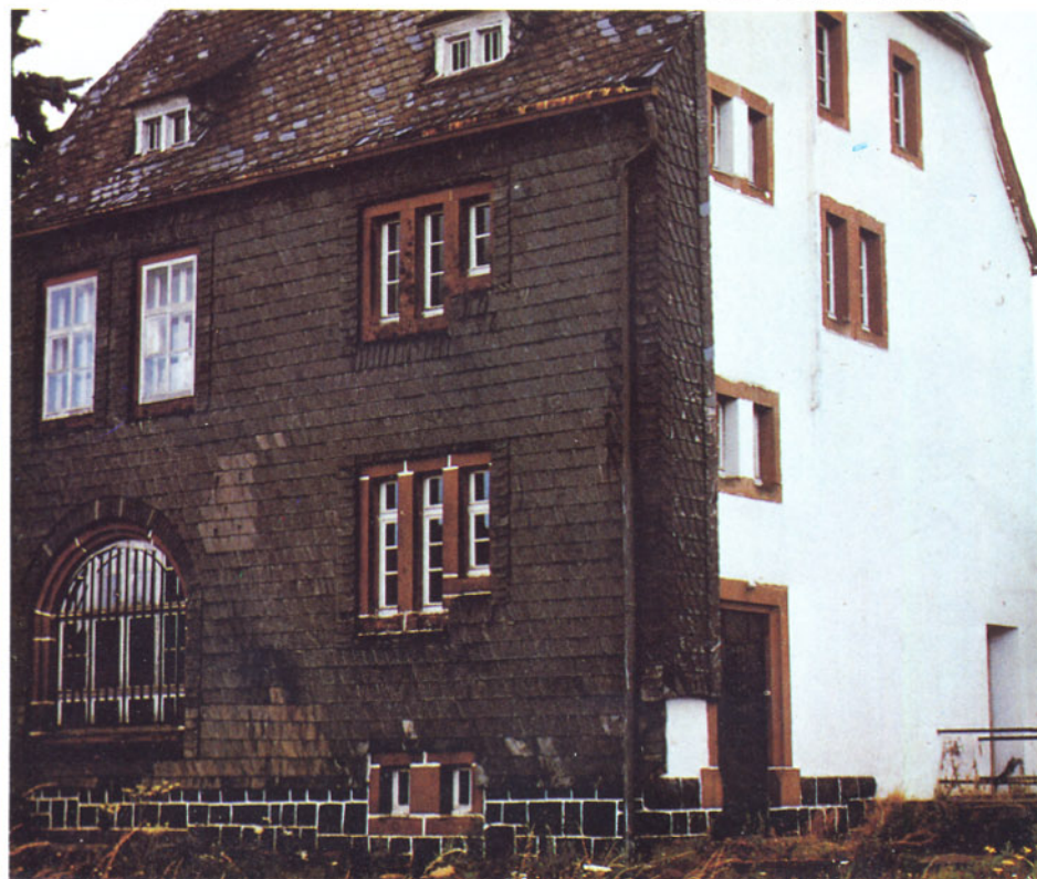
Bild 15: Typisch für die Bahnhofsgebäude an der Ahrtalbahn war die schützende Schiefertäfelung der Fassade auf der "Wetterseite". Fotos 14 und 15: B. Theisen
