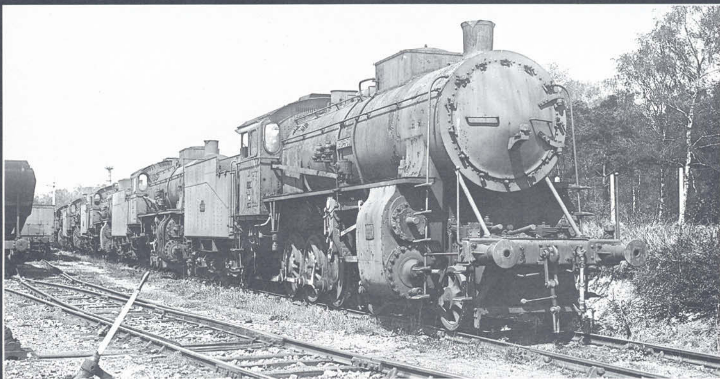
Bild 15: Um 1935/36 entstand in einem französischen Bahnhof diese Aufnahme, die mehrere abgestellte Lokomotiven der bayerischen Gattung G 4/5 H zeigt. An vorderster Stelle steht die 140-950 der ETAT, die 1918 von Maffei gebaut worden war (Fabrik-Nr. 4962) und zunächst die bayerische Betriebsnummer 5675 erhalten hatte.
