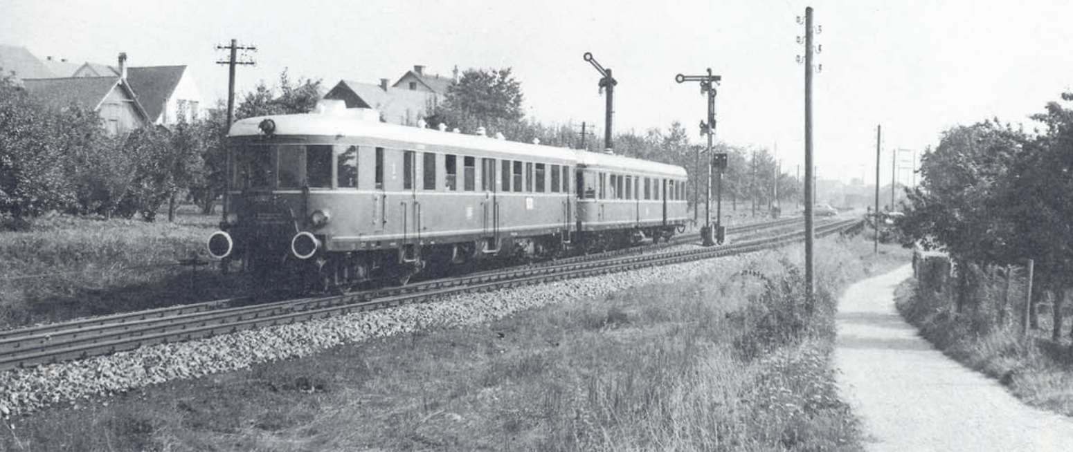
Bild 5: Der einzige Einheitstriebwagen nach dem "Essener Grundriß" aus der Fertigung von M.A.N., der zur DB gelangte, war der VT 32 002. Der bis 1947 als 137 074 bezeichnete Triebwagen verläßt mit dem VS 145 262 als Personenzug 3070 soeben den Bahnhof Nonnenhorn (15.09.1963).
