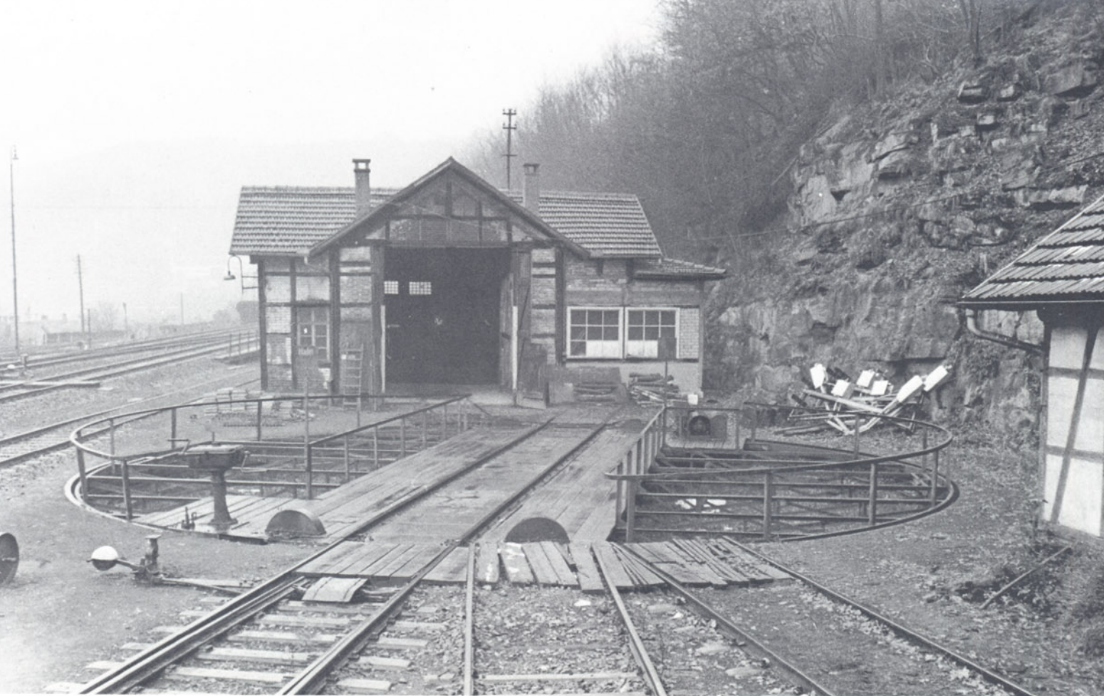
Bild 1: Die zwischen den beiden Schuppen angeordnete Drehscheibe mit einem Durchmesser von 16,10 m.
