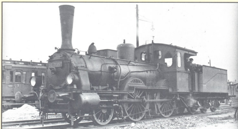
Bild 14: Die 34 7351 der Deutschen Reichsbahn wurde 1896 von Schichau an die Mecklenburgische Friedrich-Franz-Eisenbahn geliefert (Fabrik-Nr. 837). Ihre Bauform stimmt mit der der preußischen Lokomotiven nach Musterblatt III-1 weitgehend überein.
