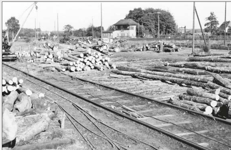
An der Nordwestseite des Bahnhofs entstand ab 1964 aus einer kleinen Sägehalle das Palettenwerk Bassum. Den Transport zwischen Holzlagerplatz und Gattersäge übernahm anfangs eine kleine Lorenbahn. In den Bildhintergründen sind das Nordstellwerk und der gegenüberliegende Wasserturm zu erkennen.
