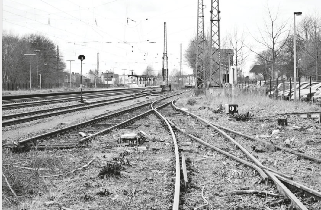
Die im Frühjahr 2014 begonnene Modernisierung der Verkehrsstation verlangte unter anderem eine Modifizierung der auf der Westseite liegenden Gleisanlagen und bedeutete das Aus für weitere der schon lange ungenutzten Gütergleise samt der hier zu sehenden Weichen 25 und 26. Garrett Riepelmeier
