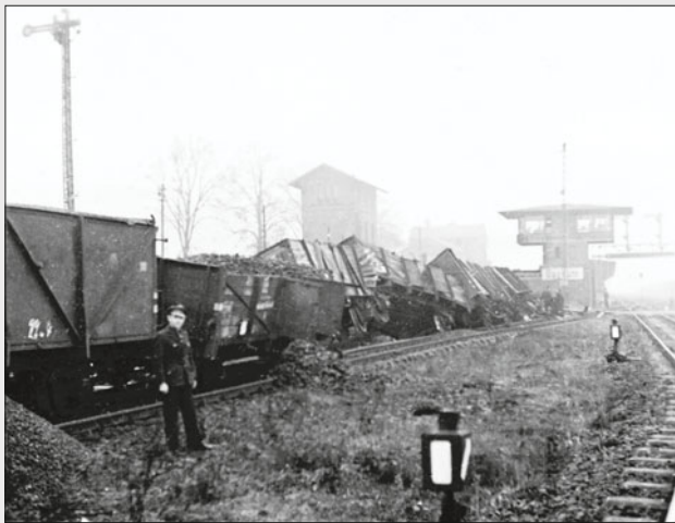
Anfang der 1950er Jahre ereignete sich am südlichen Bahnübergang unmittelbar neben dem Stellwerk Bs ein Güterzugunfall, bei dem zahlreiche O-Wagen entgleisten und ihre Ladung verloren. Während die örtliche Kleinlok bei den Aufräumarbeiten half, wurde der Güterverkehr aus Süden – zu sehen ist ein mit einer 41 bespannter Eilgüterzug – über die Ostseite geführt.
