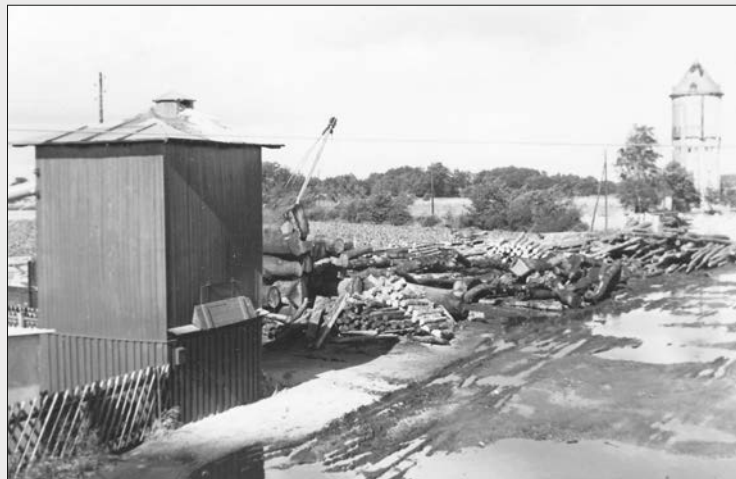
An der Nordwestseite des Bahnhofs entstand ab 1964 aus einer kleinen Sägehalle das Palettenwerk Bassum. Den Transport zwischen Holzlagerplatz und Gattersäge übernahm anfangs eine kleine Lorenbahn. In den Bildhintergründen sind das Nordstellwerk und der gegenüberliegende Wasserturm zu erkennen.
