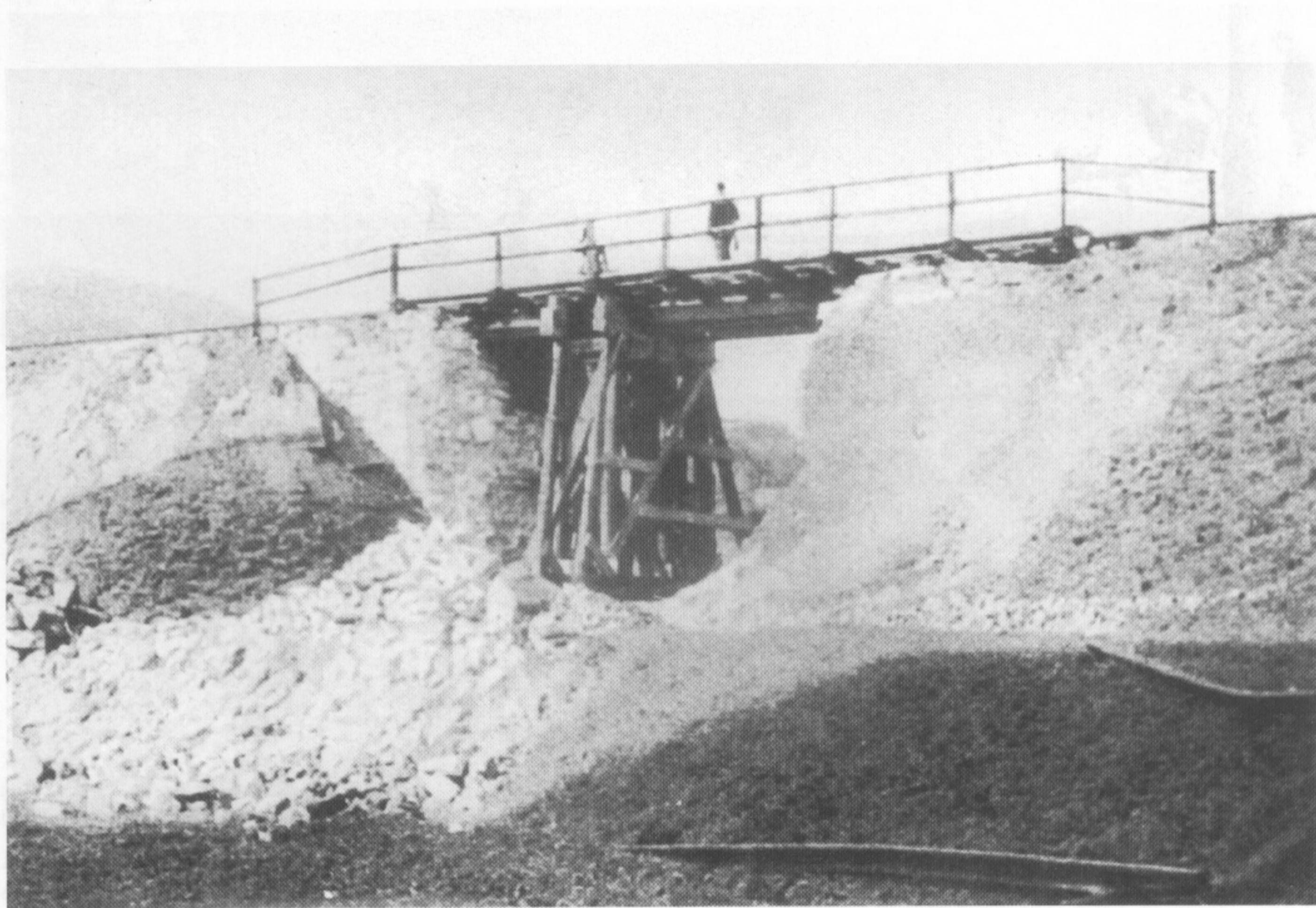
Hier: Eisenbahnbrücken werden mit behelfsmäßigen Mitteln wieder hergestellt. Während der Besetzung der tschechischen Grenzgebiete kommen die neu aufgestellten Eisenbahn-Pionier-Truppen erstmals zum Einsatz.
