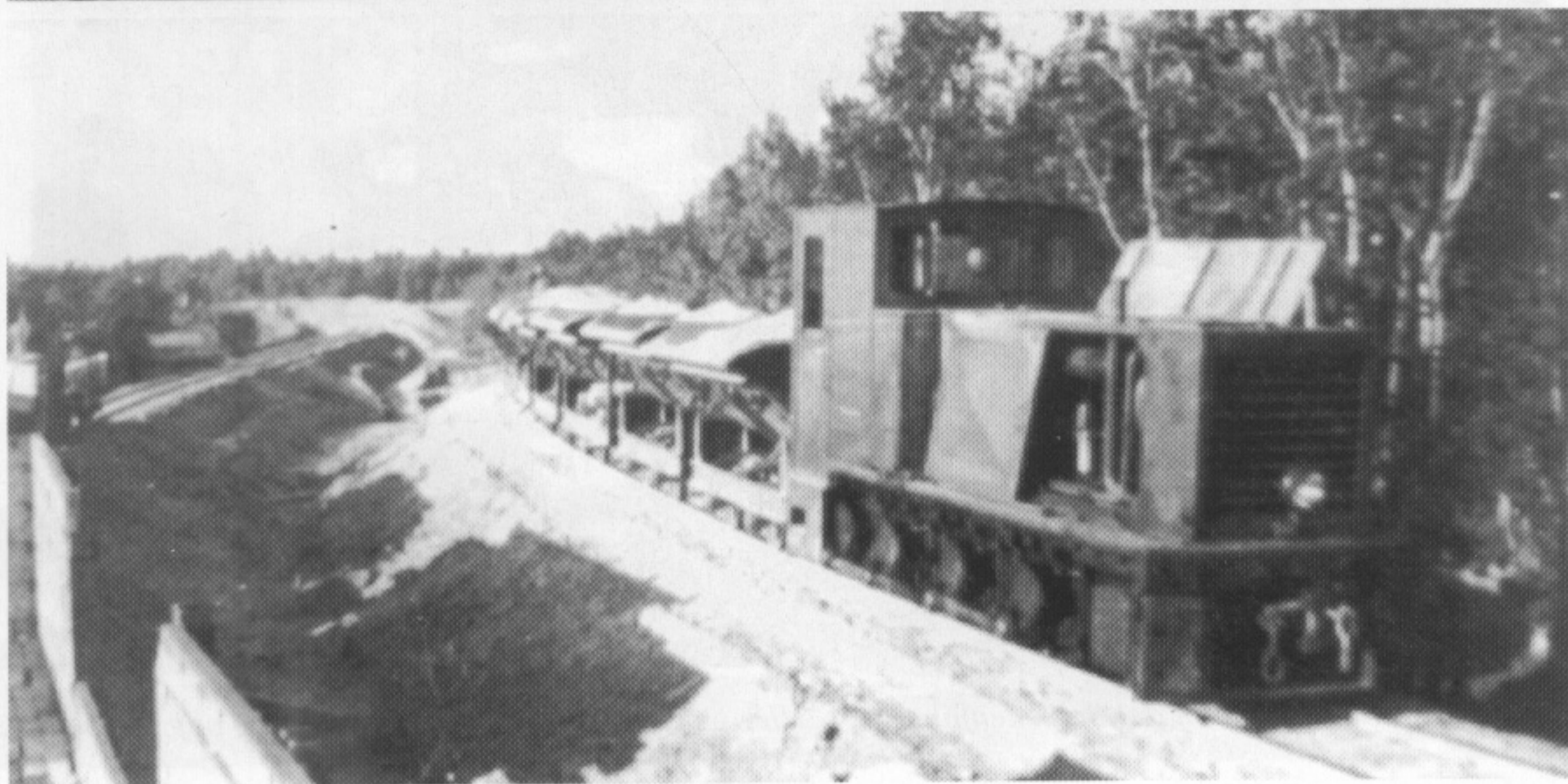
Heeresgruppe Mitte 1942/43; Mit 341 Stück war die dieselhydraulische Schmalspurlokomotive HF 130 C 5,5 die bekannteste und meistgefertigte Motorlok der Wehrmacht.
