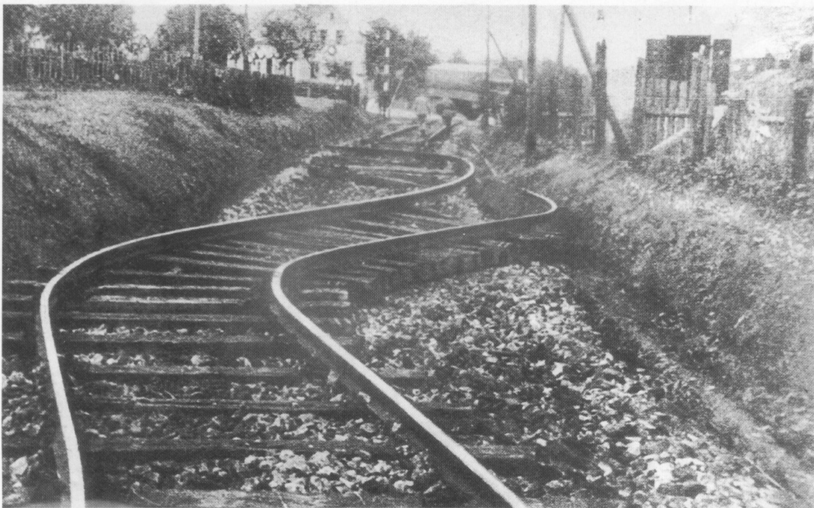
Beim Einmarsch der Wehrmacht ins Sudetenland hatten die tschechoslowakischen Streitkräfte zahlreiche Grenzstrecken mit Schienenaufreißmaschinen unbrauchbar gemacht.
