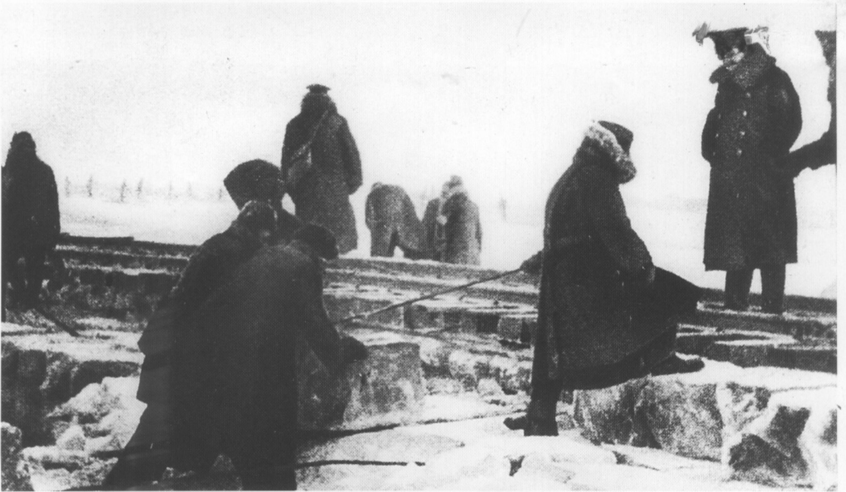
Eisenbahnpioniere der Wehrmacht verlegen über das Eis des Ilmensee (Rußland) ein Eisenbahngleis. Unter ihrer Leitung setzen hilfswillige sowjetische Gefangene (Hiwi) Eisblöcke zu einem Eisenbahndamm zusammen.
