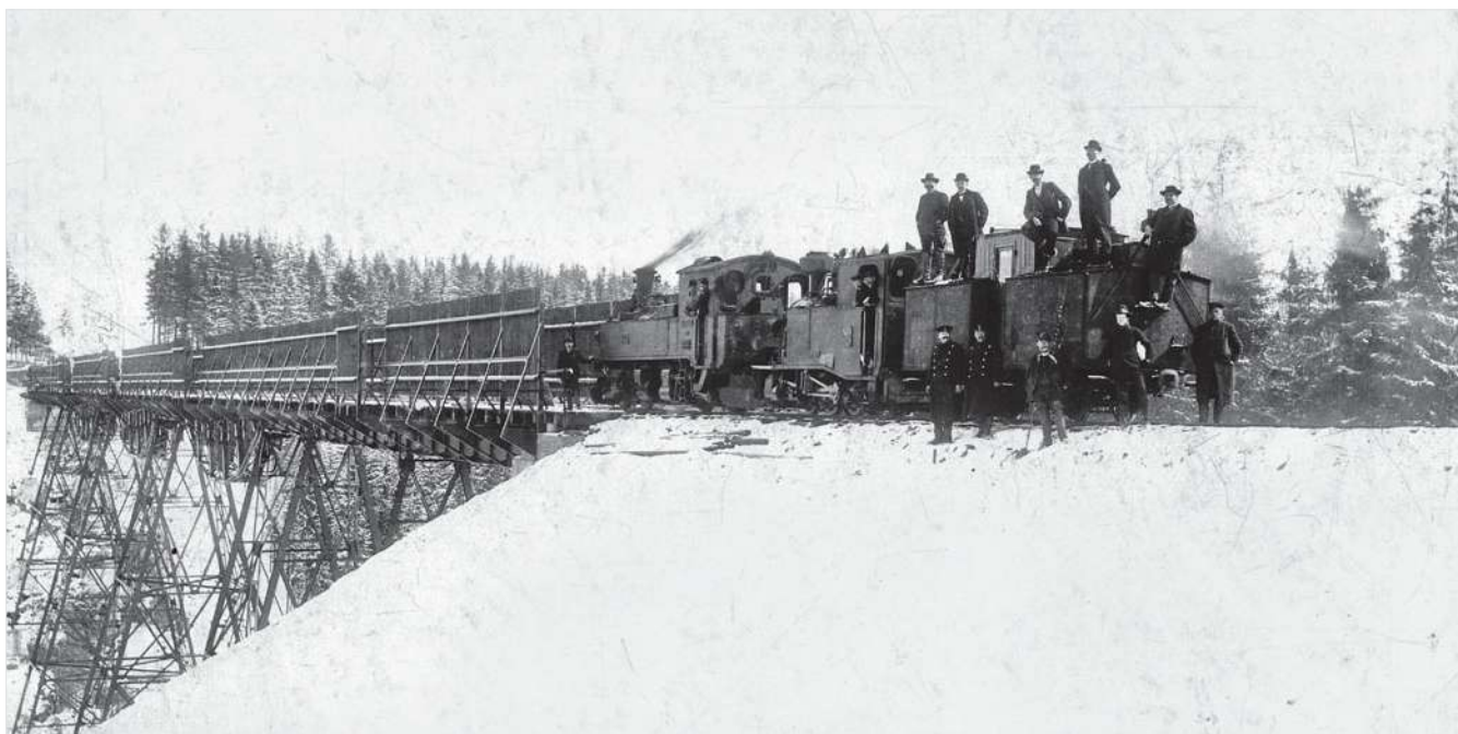
Das Auftauchen dieses Motivs von der Belastungsprobe des Greifenbahntalviaduktes glich einer kleinen Sensation. Es ist die bisher einzige bekannte Darstellung des schmalspurigen Brückenprüfwagens. Die regelspurige Version ist fast baugleich. Höchstwahrscheinlich sind die beiden Vorbauten Wasserkästen, mit denen das Gewicht des Wagens abgehoben werden kann.
