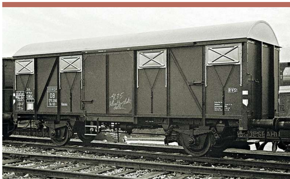
Neubauwagen – wie der von Fritz Willke in Stuttgart 1965 aufgenommene Gmms 60 175266 – mussten von vornherein ohne Sprengwerk auskommen (Sammlung SC).
