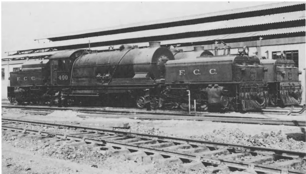
Zwei Garratts der Central Railway of Peru mit umgebautem Schornstein ausser Dienst hinterstellt in Chosica im Jahre 1966.
