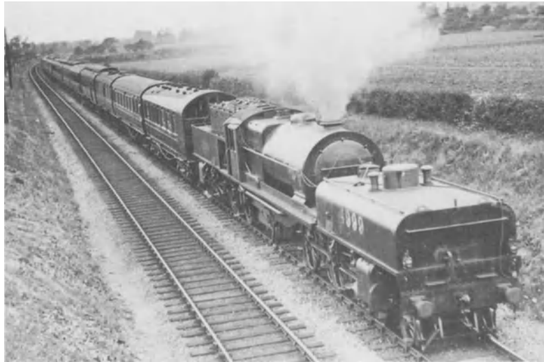
Die Garratts der LMS waren infolge ungünstiger Auslegung der Steuerung und zu knapp bemessenen Lagern für hohe Geschwindigkeiten nicht geeignet. Trotzdem unternahm man optimistisch Testfahrten. Die als erste ihrer Reihe gebaute Lok Nr. 4999 mit kurzem Schornstein und normalem Kohlebunker zeigt sich hier mit Expresszugstirnlampensignal auf Probefahrt mit Messwagen und einem Leerzug um 1930.
