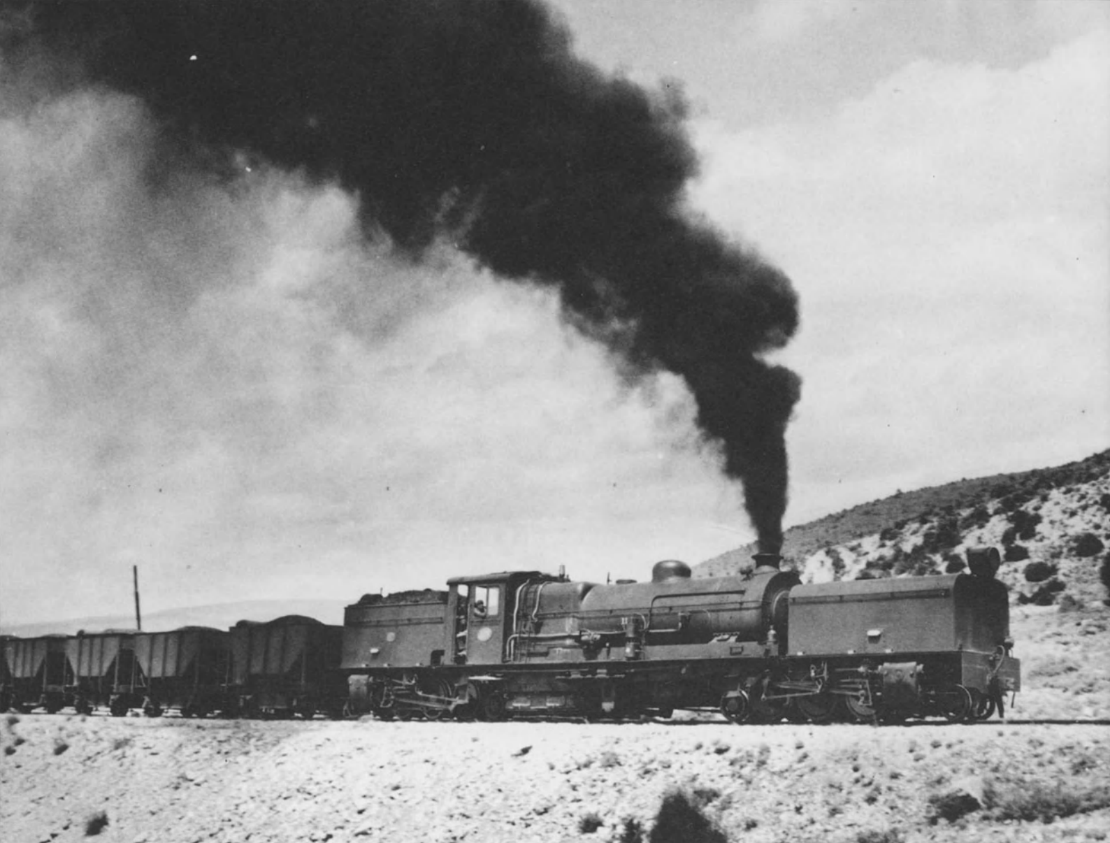
Lok 502 der Sierra Menera vor einem Erzzug von Teruel nach Puerto del Escandon mit einer CC-Mallet als Schiebelok im Jahre 1962. Diese Garratt wurde 1965 auf Ölfeuerung umgebaut und im Schiebedienst eingesetzt. A. E. Durrant
