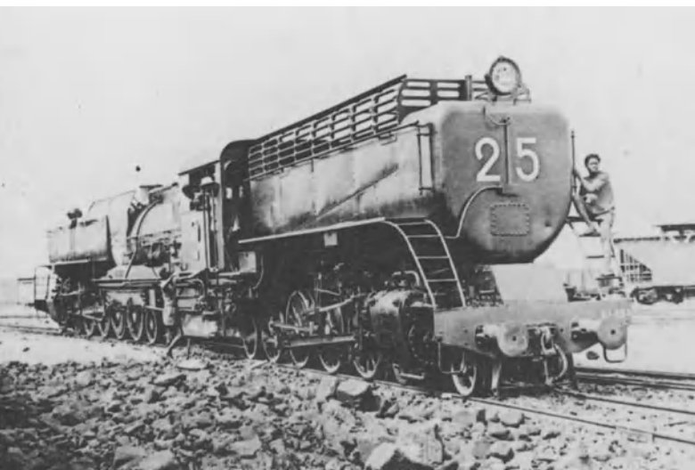
Die hier gezeigte Lok Nr. 93225 der Abidjan-Niger-Bahn in Elfenbeinküste wurde als westafrikanische Version aus den algerischen Schmalspur-Garratts abgeleitet. La Vie du Rail
