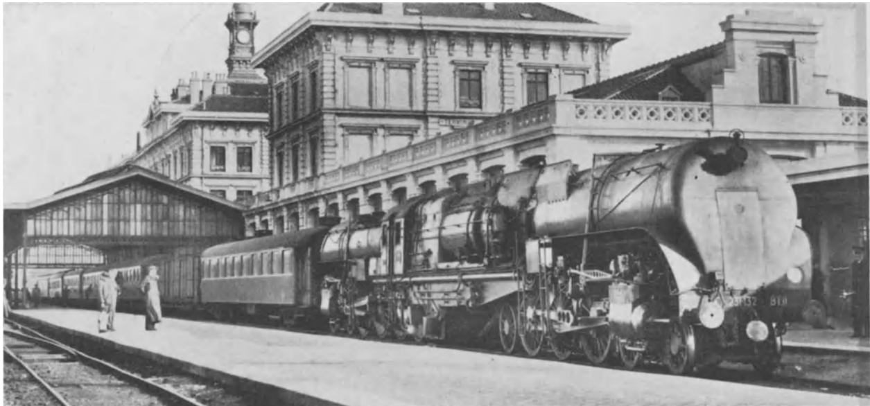
Eine der bemerkenswerten stromlinienförmigen Schnellzug-Garratts für Algerien mit Cossart-Ventilsteuerung im Hafenbahnhof von Calais vor einer Probefahrt mit einem Schnellzug nach Paris. Sammlung des Autors
