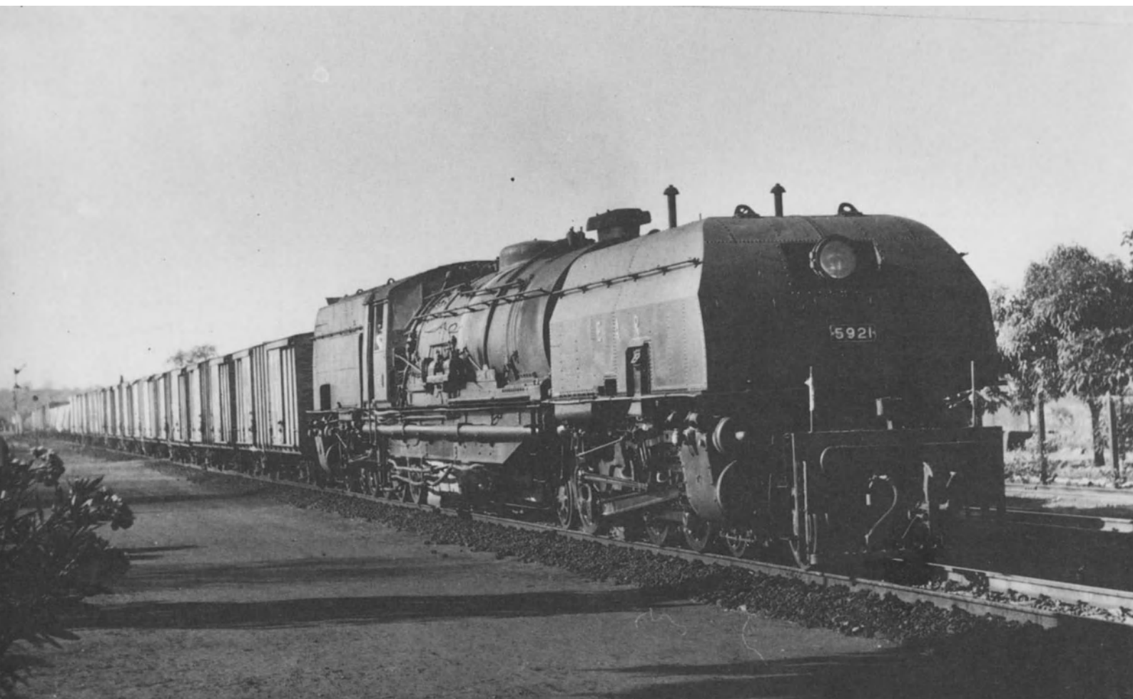
Unten: EAR-Lok Nr. 5921 Mount Nyiru vor einem langen Güterzug bei der Durchfahrt in einer typischen gut instandgehaltenen Zwischenstation. 20 Jahre härteste Arbeit liegen hinter der Maschine. Für den Ersatz einer Lok Klasse 59 sind zwei grosse Dieselloks nötig.
