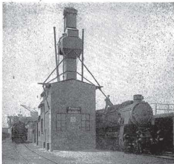
Bild 10 Besandungsanlage
