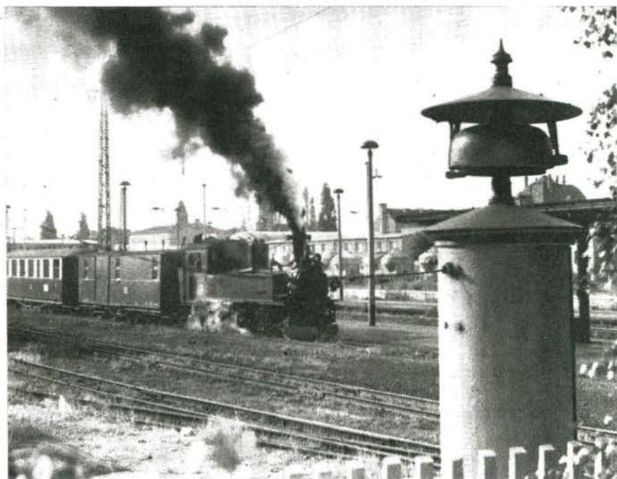
1 Blick auf den Bahnhof Radebeul Ost am 24. Juli 1983. Der Traditionszug wird bereitgestellt. Das Lätewerk erinnert an die Sicherungstechnik der Eisenbahn, die nun schon lange der Vergangenheit angehört.
