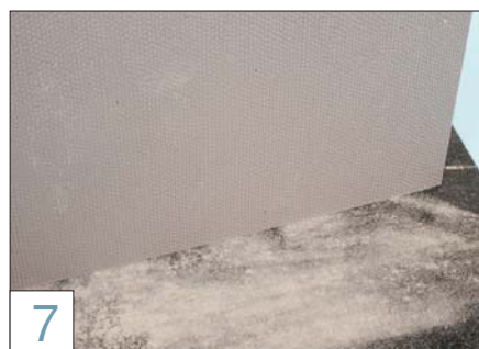
7 Die Schnittkanten werden auf einem ebenflächig fixierten Schleifpapier begradigt. Die Platte wird dabei leicht schräg gehalten.
