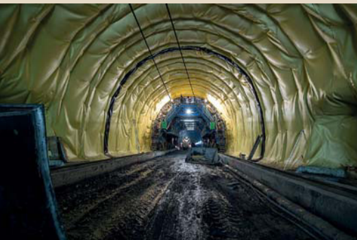
Zwischen Gestein und Betonverschalung wird eine Kunststoff-Abdichtung eingebaut.
