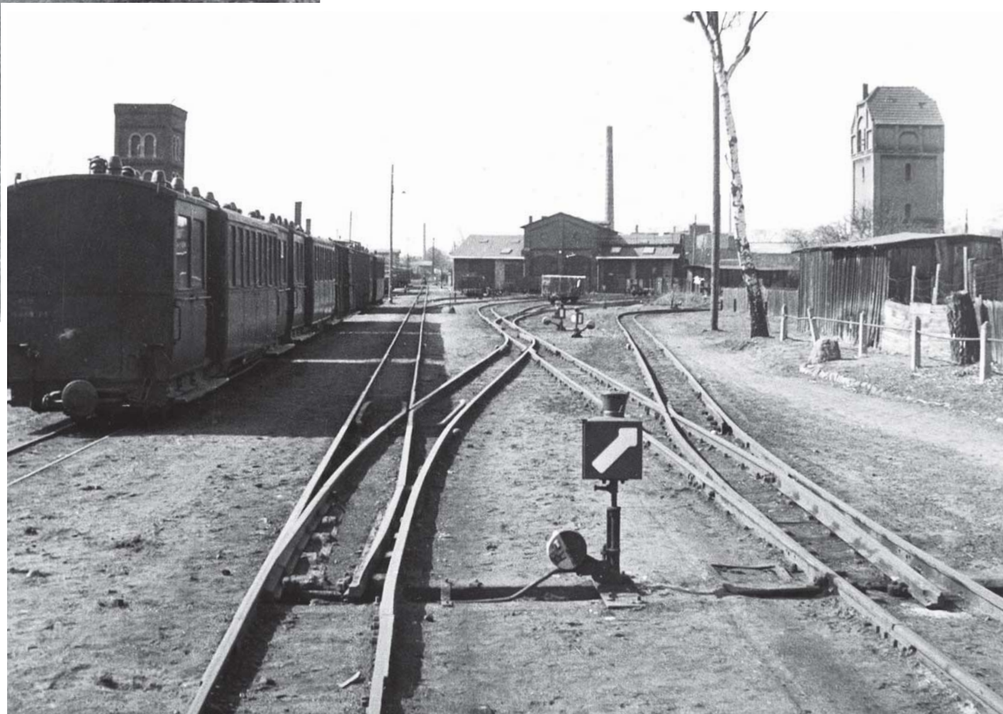
In die ehemalige MPSB-Betriebswerkstatt führten ausschließlich 600-mm-Gleise. Auf Drehgestellen gelangten aber auch 750-mm-Wagen dorthin, um in der ab 1950 als Werkabteilung Friedland des Raw Malchin bezeichneten Werkstatt aufgearbeitet zu werden.
