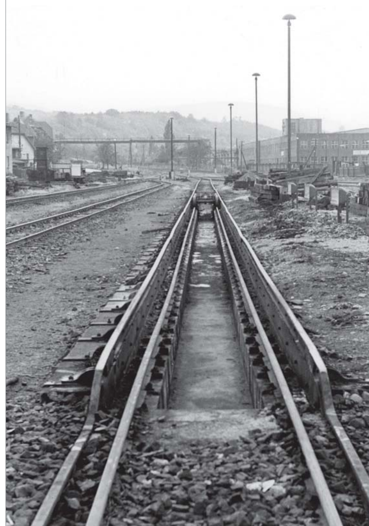
Eine ganz andere Bauform als in Nordhausen hatte die Rollbockgrube in Wernigerode Umladebahnhof, Foto vom 22. Juni 1972. Über eine „Rampe“ am Ende der Rollbockgrube setzten die Radsätze der Normalspurgüterwagen plötzlich auf den Rollbock auf.
