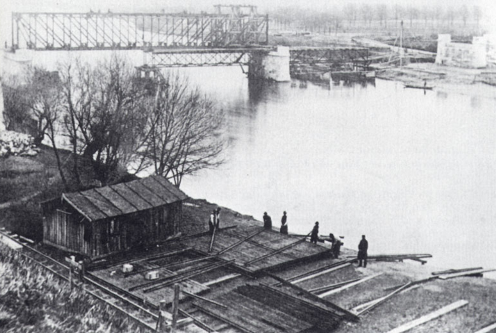
Bild 16: Dieses Foto vom Bau der Donau-Brücke bei Ingolstadt zeigt, daß um 1868 die Baumaterialien noch auf dem Wasserweg transportiert und von der Lände mit einer schmalspurigen Baubahn zur Baustelle gebracht wurden. Foto: Sammlung Bergsteiner
