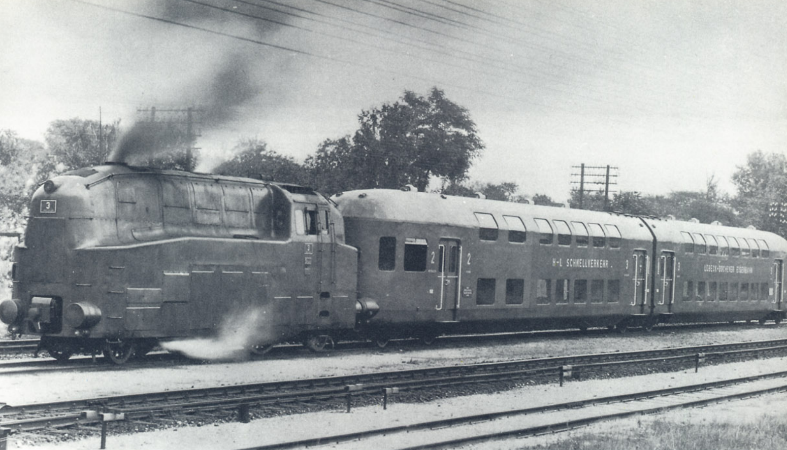
Bild 9: Die LBE 3 mit einer Doppelstock-Garnitur in Ahrensburg. Sie wurde erst 1937 von Henschel gefertigt (Fabriknummer 23 382), erhielt einen größeren Kessel, eine etwas geänderte Verkleidung und größere Wasserbehälter (siehe auch Abbildungen 7 und 8). Bei der DR erhielt sie die Loknummer 60 003 und aufgrund der etwas höheren Achslast das Gattungszeichen St 24. 19.
