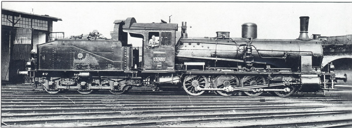
Bild 10: Wieder eine Cölner, von der Hanomag 1908 als Fabriknummer 5118 gebaut, und als (G 7) Cöln 4547 abgeliefert. Nach dem Ersten Weltkrieg war sie im Verschiebedienst tätig. Bei dem naßkalten Nebelwetter am Niederrhein wird das Personal die Führerhaus-Rückwand sicher begrüßt haben. Über den Verbleib der 55 455 ist nichts bekannt.
