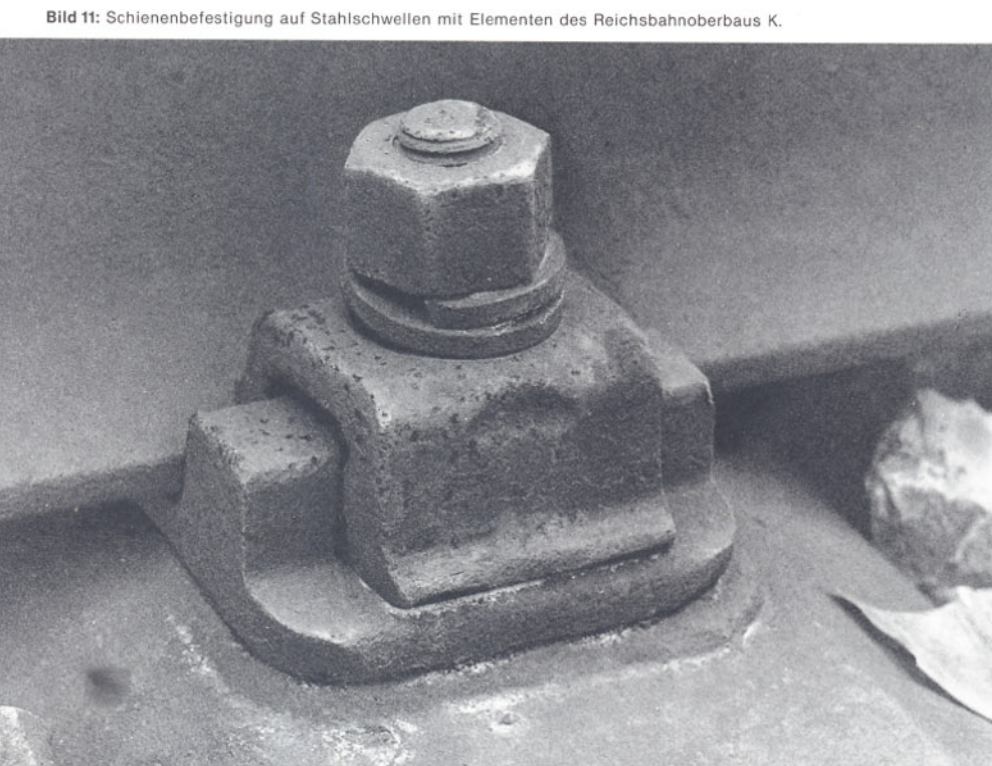
Bild 11: Schienenbefestigung auf Stahlschwellen mit Elementen des Reichsbahnoberbaus K.
