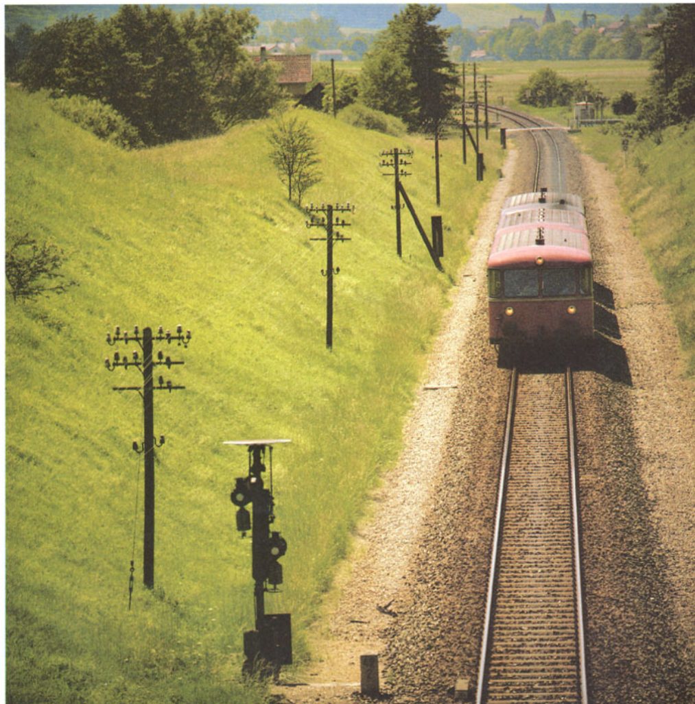
Bild 13: Obwohl es sich hier nicht um eine mehrgleisige Hauptstrecke handelt kann man gut erkennen, wie leicht geschwungen die Kurven einer Vollbahn beim Vorbild sind. Interessant für den Modellbauer ist auch die Banquetteschüttung neben dem geschotterten Damm. Hier dürfte sich früher ein Wassergraben befunden haben, der mittlerweile Drainageröhren erhalten hat. Für den Modellbauer sicher eine gute Gestaltungsanregung.
