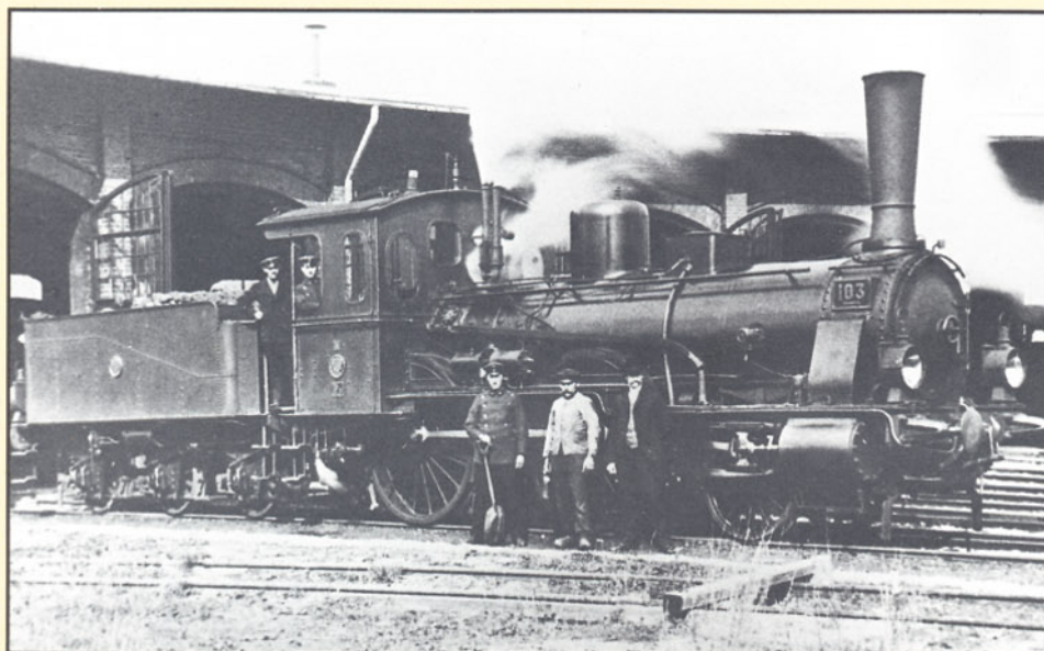
Bild 5: Grafenstaden lieferte 1889 mit der Fabrik-Nr. 3875 die Hannover 103 (2. Besetzung). 1906 wurde sie zur (P 3) Hannover 1604. Das Foto wurde 1904 in Herford aufgenommen. Foto: L. Fricke
