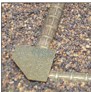
KTD THD: (falsch montierte) Weichendraht- zugablenkung
