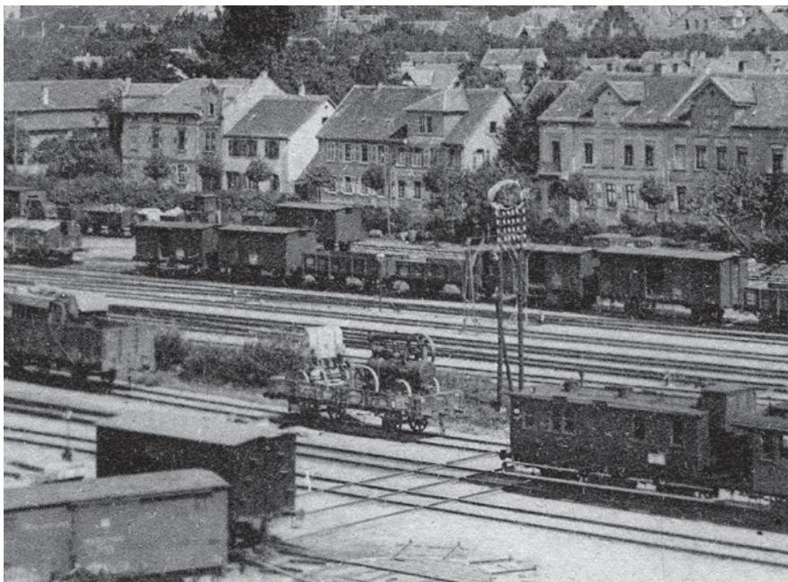
Ausschnitt aus einer Postkarte von 1901: Im Bahnhof von Bensheim (Hessen) steht ein auf einem Niederbordwagen verladenenes Lokomobil. Das zweite Gerät könnte eine Dreschmaschine sein.
