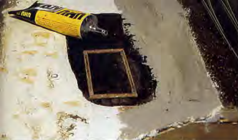
Bild 84: Die Einfassung für die Fahrzeugwaage wird aus Kunststoffstreifen auf die Grundplatte aufgeklebt.
