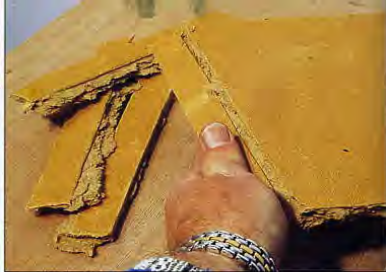
Bild 140: Eine Jura-Schichtsteinmauer wird aus Dämmplatten gestaltet. Zuerst erfolgt das Anritzen mit dem Messer.
