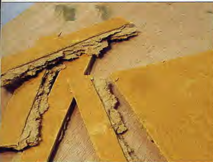
Bild 140: Eine Jura-Schichtsteinmauer wird aus Dämmplatten gestaltet. Zuerst erfolgt das Anritzen mit dem Messer.
