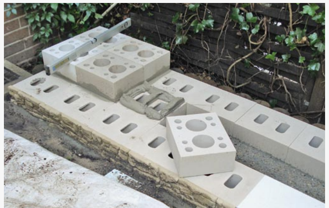
Mauern der Aufstockung zum Höhengewinn. Die hinteren Reihen Kalksandstein bilden selbst die Kulisse oder dienen als Basis für die Natursteine.
