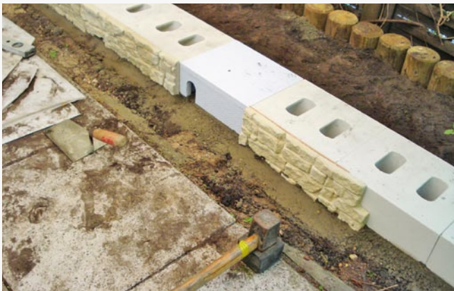
Die Vorderseite der Kalksandsteine wird mit Verblendern verkleidet.
