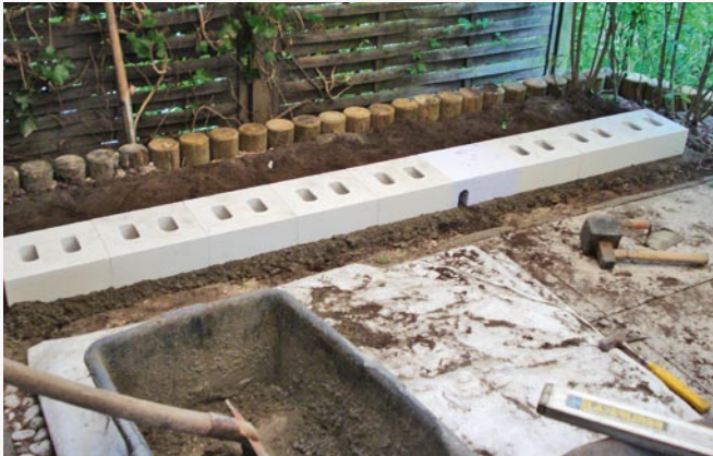
Der erste Grundstock sitzt, der helle „Stein“ dazwischen ist ein Block aus Styrodur.
