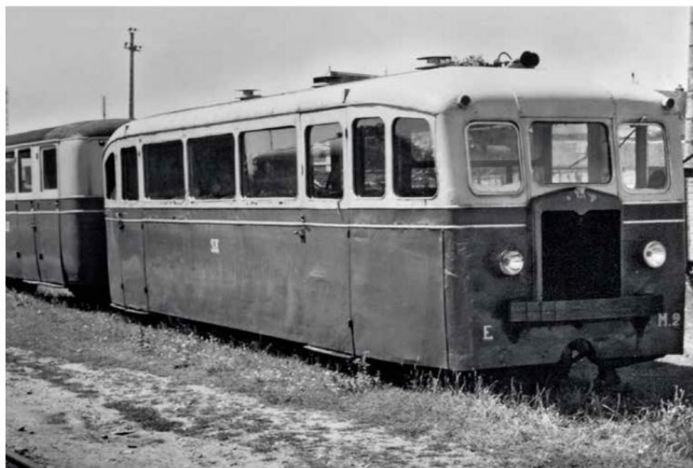
En 1937, le réseau des bains de mer débute sa modernisation par l'acquisition de dix autorails à deux essieux De Dion-Bouton type NJ. Unidirectionnels (il faut les tourner au terminus) et équipés d'un diesel Unic de 85 ch, ils sont immatriculés M1 à 10. Ici, le M2 en 1953.
