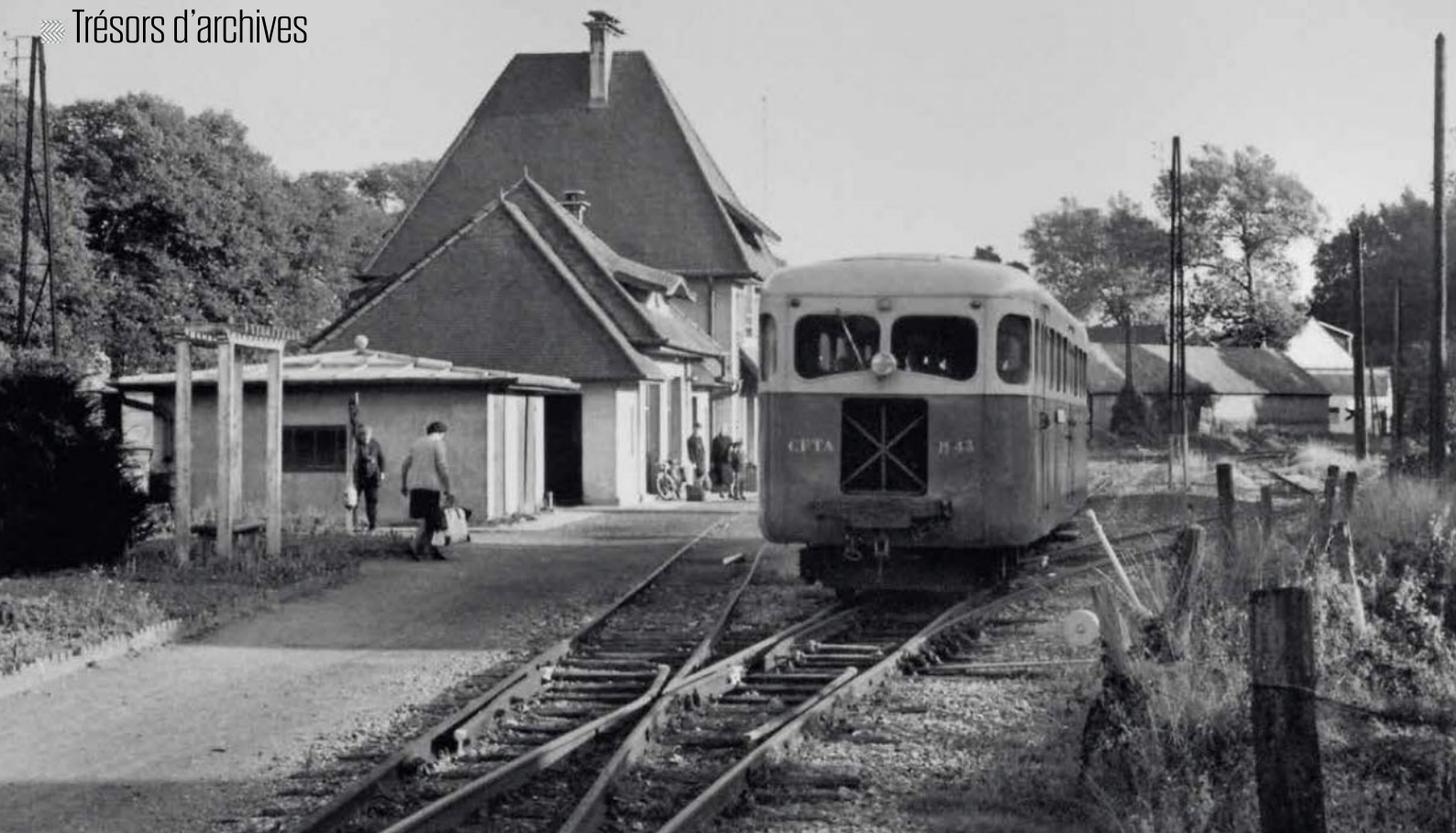
Le M43 en gare de Saint-Valéry-Ville. Cet autorail a été construit en 1936 par les Ateliers CGL de Lumbres. Monté sur un châssis à bogies et motorisé par un diesel Berliet de 115 ch, lui et son frère – le M 42 – avaient circulé avant-guerre sur la ligne Persan-Beaumont/Hermes.
