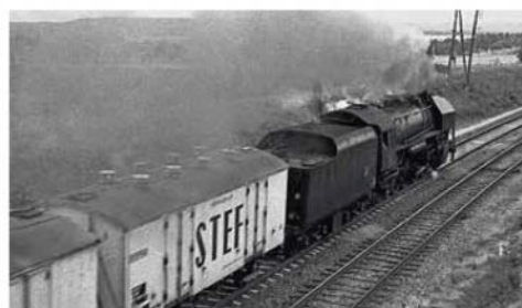
19 juin 1969: une 141 R de Nevers tracte un train du RA acheminant des wagons réfrigérants STEF au nord de la Ferté-Alais sur la voie paire. On distingue les traverses en béton monobloc sous les wagons.
