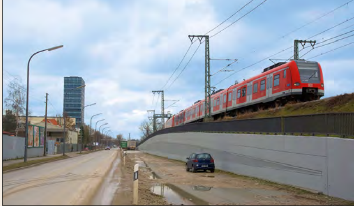
Die Stützmauer schafft Platz für die Tram: Das Bauwerk zwischen Straße und Bahnstrecke wurde zeitlich getrennt vom Tramneubau errichtet
