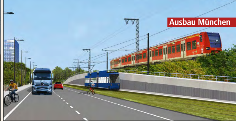
Die Stützmauer schafft Platz für die Tram: Das Bauwerk zwischen Straße und Bahnstrecke wurde zeitlich getrennt vom Tramneubau errichtet
