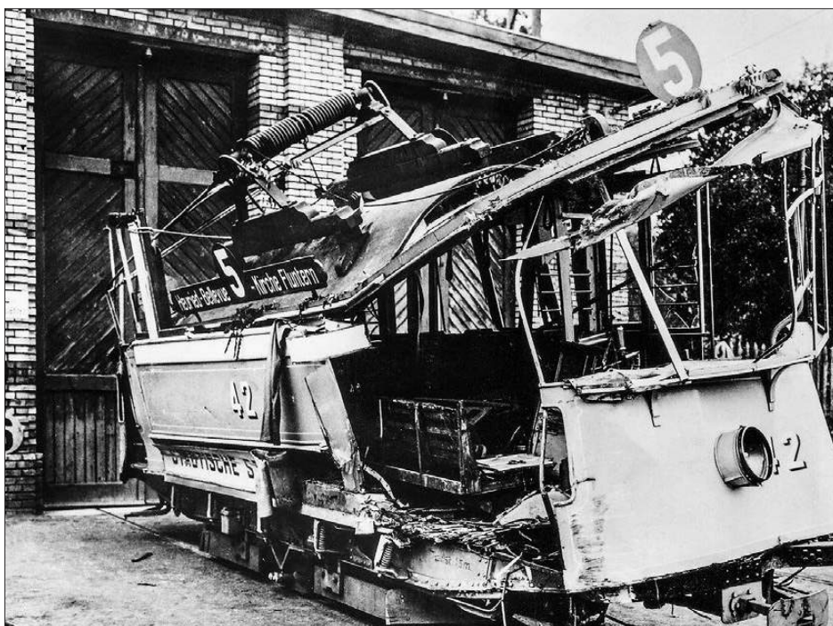
Der Ce 2/2 Nr. 42 entlief im Jahr 1920 im Depot Fluntern und zerschellte bei der Spitzkehre am Haldeliweg an einem Gartenzaun. Das Bild zeigt, wie gebrechlich die Holz-Wagenkasten waren
