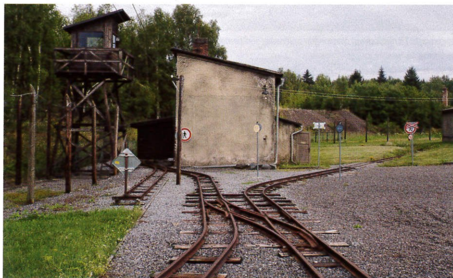
Lešetice Vojna. Wybudowana na terenie obozu w 2013 roku górnicza kolejka w formie pętli o długości 300 m i szerokości toru 600 mm w sezonie turystycznym 2017 była nieczynna.
