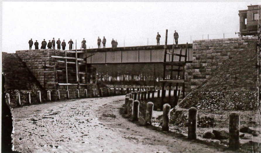
Wiadukt w Wandzinie nad obecną DK19. Zdjęcie wykonano prawdopodobnie w trakcie przejazdu inspekcyjnego w zimie 1897 roku tuż przed oficjalnym otwarciem linii. Uwagę zwraca brak drugiej konstrukcji mostowej, która – jak pozostałe konstrukcje mostowe – została zbudowana na drugim torze w latach 1902–1904 r.
