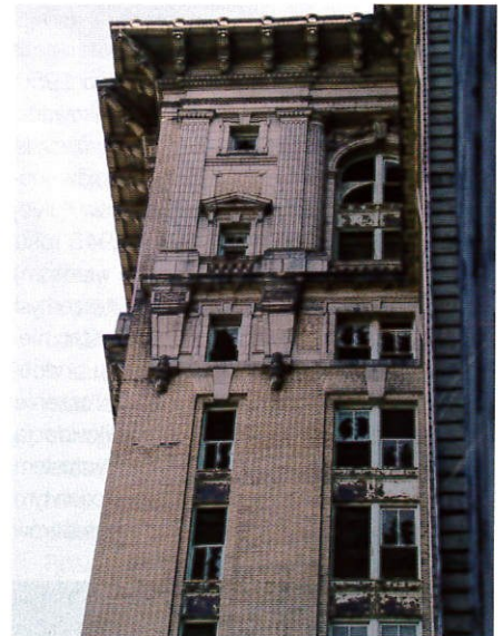
Fragment zwieńczenia elewacji budynku biurowego z dekoracyjnymi pilastrami, opaskami okiennymi i krosztynami wspierającymi gzyms koronujący.
