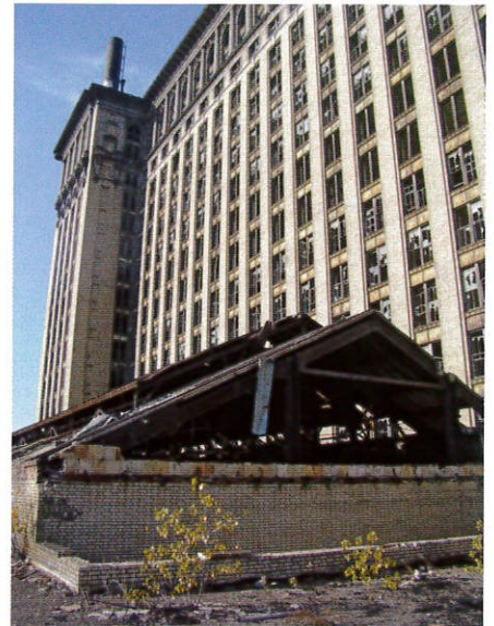
Pozostałości przeszklonego niegdyś świetlika znajdującego się ponad halą główną.
