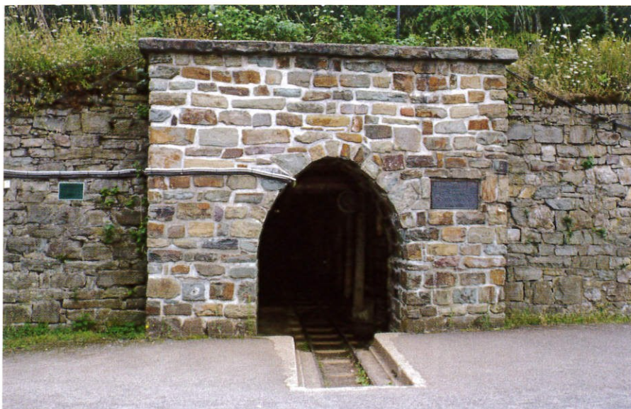
Szyb Anna, początek podziemnej trasy górniczej kolejki o szerokości toru 450 mm w sztolni Prokopskiej.
