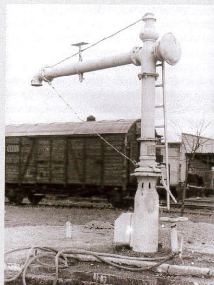
Na linii d. kolei Brzesko-Grajewskiej najdłużej w Polsce zachowały się rosyjskie żurawie wodne; na zdjęciu urządzenie tego typu, w piecyk do ogrzewania kolumny wodnej, na terenie MD Czeremcha, 21.10.1983 r. Fot. K. Koj
