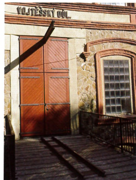
Przeszło torowe o rozstawie szyn 450 mm przed budynkiem szybu Wojciech.
