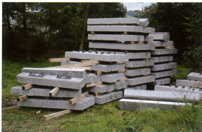
Podkłady strunobetonowe składowane na wysokości mety toru regatowego, na pierwszym planie podkłady z mocowaniem typu K, 25.09.2017 r.
