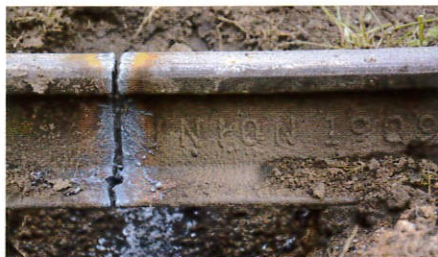
Demontaż odcinka toru zbudowanego z najstarszych szyn sygnowanych Union 1909 – mijanka Balbinka, 25.09.2017 r.
