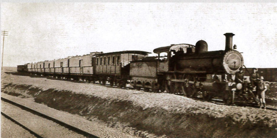
Rzadkie zdjęcie brytyjskiego pociągu wojskowego w Palestynie podczas I wojny światowej na głównej linii z Egiptu do Hajfy. Za lokomotywą parową egipskich kolei państwowych (ESR) zbudowaną w USA (ukł. osi 2-2-0, z serii parowozów ESR oznaczonych numerami inw. 602-611, Baldwin Locomotive Works 18129-18131 i 18149-18155/1900) trzyosioowy wagon pasażerski, dalej kompletny pociąg sanitarny London & South Western Railway (LSWR) i wagony bagażowe. Przed parowozem prawdopodobnie maszynista i palacz oraz żołnierz z załogi pociągu. Kolekcja Alon Siton
