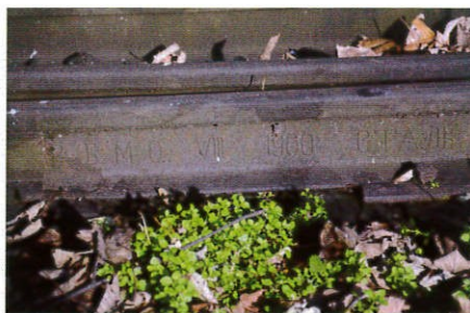
Pisane cyrylicą nazwy zarządów kolejowych na szynach o wysokości 130 mm, z których wykonano rozjazdy, od lewej: 1903 r., 1900 r., 1914 r.
