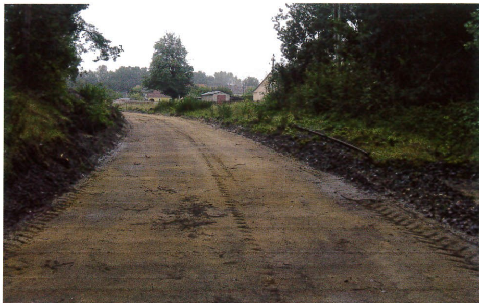
Wykorytowany pod ułożenie nowego toru wyjazd z Przewozu w kierunku Sanic, po prawej resztki toru bocznego tartaku; w tym miejscu w II poł. lat 20. znajdował się przystanek Przewóz Pd. Fot. T. Jerczyński (1.09.2017)
