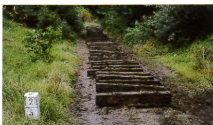
Kilometr 2,3 – podkłady po wymianie przeprowadzonej w 2001 roku ciągle były w niezłym stanie, nowe życie znajdują w Białosłiwu; 25.09.2017 r.
