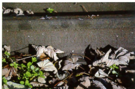
Pisane cyrylicą nazwy zarządów kolejowych na szynach o wysokości 130 mm, z których wykonano rozjazdy, od lewej: 1903 r., 1900 r., 1914 r.
