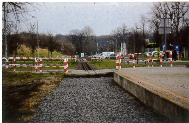
Nowy przystanek Ptyś z ułożoną warstwą tłucznia czeka na rozłożenie podkładów.
