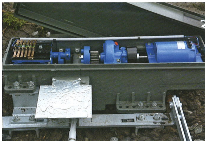
Zregenerowany napęd zwrotnicowy JEA-29 zabudowany przy rozjeździe nr 2, 26.04.2018 r.
