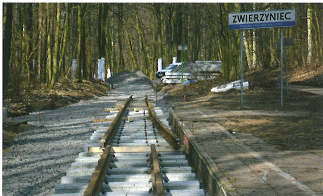
Widoczny jeszcze stary peron odjazdowy, tor kończy się przed brakującym rozjazdem prowadzącym na żeberko ochronne, 22.02.2018 r.
