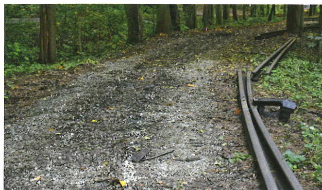
Po lewej: Jeden z podręcznych składów materiałowych, zlokalizowany przy ul. Wileńskiej (obok przystanku Balbinka), 5.11.2017 r. Po prawej: Wjazd na pętlę Zwierzyniec (z prawej strony widoczna stopa semafora wjazdowego, przekazanego do regeneracji) po zdjęciu starej nawierzchni. Podtorze wykonane z kłińca, w ramach remontu przeprowadzonego w 2001 roku. Obok ławy torowiska złożone zdemontowane szyny, przeznaczone do powtórnego wbudowania w tor; 25.09.2017 r.
