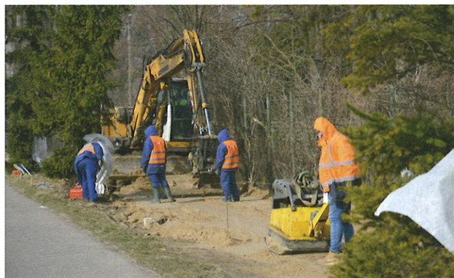
Zagęszczanie warstwy ochronnej w okolicach km 0,9, 22.02.2018 r.
