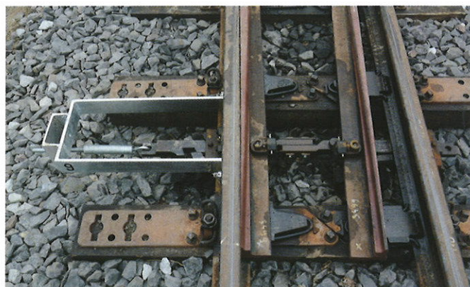
Ten sam rozjazd, ale już z zabudowanym napędem sprężynowym, 1.05.2018 r.
