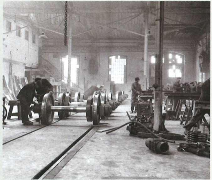
Wnętrze warsztatu napraw zestawów kołowych ZNTK Lubań, ok. 1950 r. Ze zb. Muzeum Regionalnego w Lubaniu
