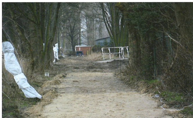
Km 0,65, widok w stronę lokogarażu – przygotowana warstwa ochronna pod podsypkę tłuczniową, 22.02.2018 r.
