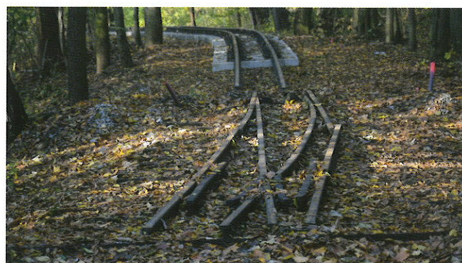
Pętla Zwierzyniec półtora miesiąca później – „wyspowo” zachowały się obydwa stare rozjazdy oraz koziół oporowy na żeberku ochronnym (widoczny tylko rozjazd wjazdowy nr 11), w głębi ułożone nowe tory, 5.11.2017 r.
