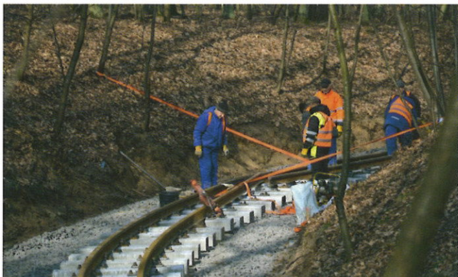
Początek prac przy kształtowaniu łuku o promieniu 30 m w pętli Zwierzyniec, 22.02.2018 r.
