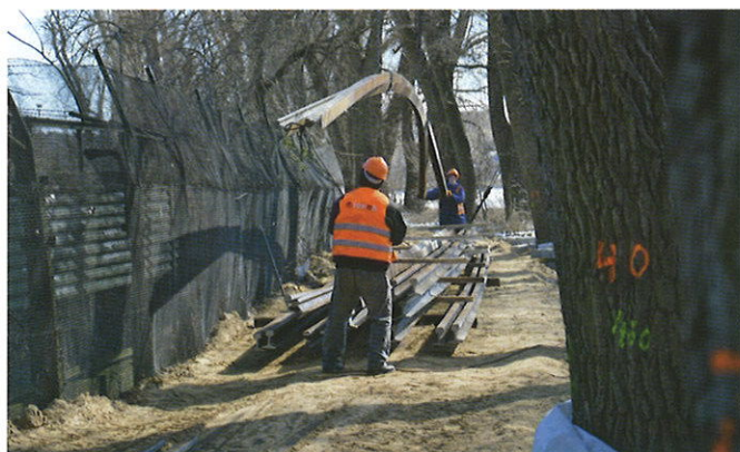
Po lewej: Rozładunek szyn dowiezionych transportem drogowym ze względu na ograniczoną przestrzeń i drzewa w bezpośredniej bliskości torowiska wymagał od operatorów dużej biegłości; 21.03.2018 r. Po prawej: Równocześnie z rozładunkiem szyny były odciągane na miejsce docelowe; 21.03.2018 r.
