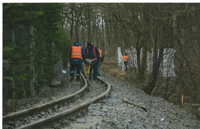
Przy wielu pracach możliwe było wykorzystanie tylko urządzeń „małej mechanizacji”; prace przy podbijaniu toru w km 1,7 (w głębi placyk po zlikwidowanym starym przystanku Płyś), 22.02.2018 r.
