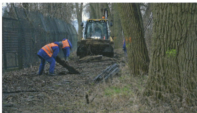
Trzeci „podetap” remontu – prace przy odcinku od km 0,55 do 1,3. Demontaż starego toru na wysokości Bazy Zieleni, 24.01.2018 r.
