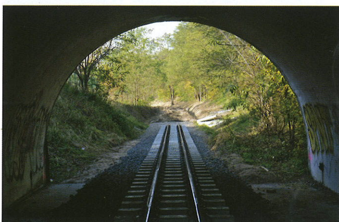
Widok na tor od strony pętli Zwierzyniec – na tym odcinku wykorzystano szyny starożytnie S42 – choć zamontowane w 2001 roku, były wyprodukowane w 1985 roku; 5.11.2017 r.
