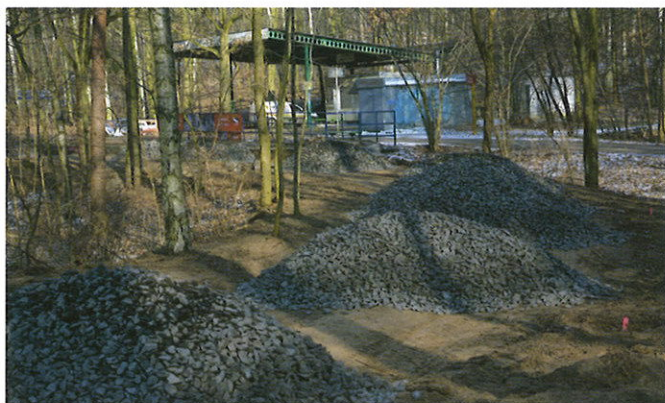
Zbliżone ujęcie, ale z tłucznem przygotowanym do rozścielenia; 8.02.2018 r.
