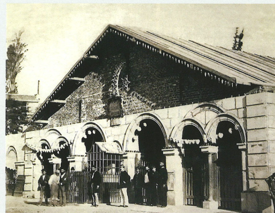
Elewacja budynku wejściowego do stacji dolnej – widoczna całkowicie odmienna (murowana) konstrukcja fasady niż w pierwotnym projekcie. Ze zb. R. Sertac Kayserilioglu
