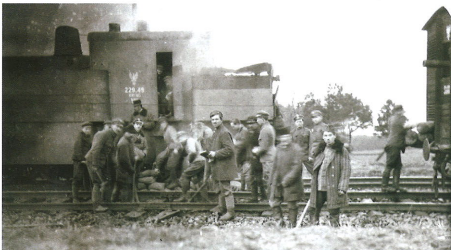
Naprawa torów kolejowych, w tle parowóz pancerny austro-węgierskiej serii 229 nr 49 (Nowy Sącz VIII) oraz fragment wagonu artyleryjskiego. Ze zb. Archiwum Nauki PAN i PAU w Krakowie
