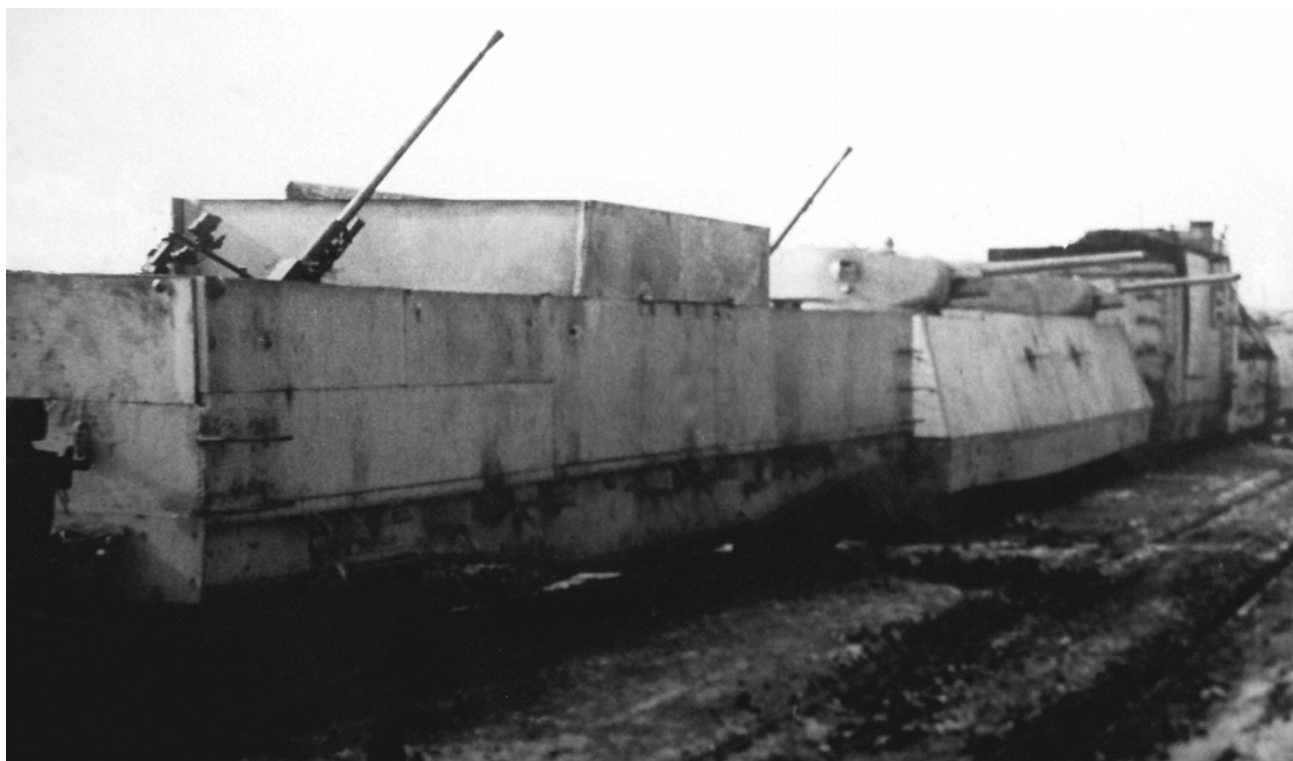
Бронепоезд № 1 «Козьма Минин» из состава 31-го особого Горьковского дивизиона бронепоездов. На переднем плане зенитная бронеплощадка с 25-мм орудиями и реактивными установками М-8. Весна 1942 года (ЦАМО).
