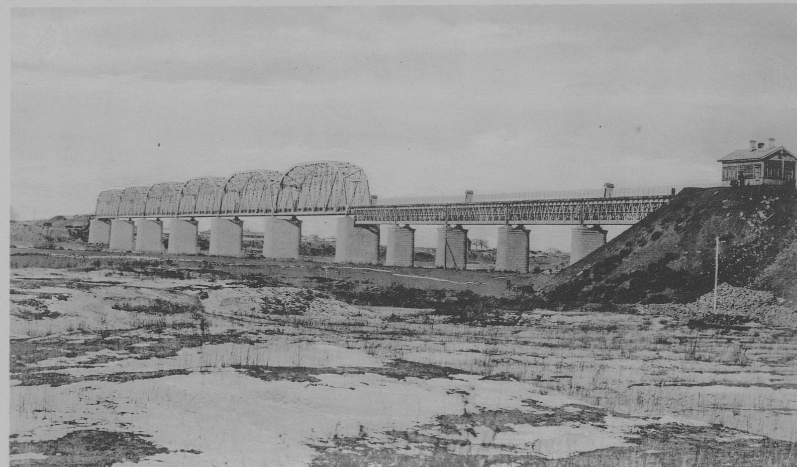
Харбинский устой с береговым быком № 2, и соединит. стѣнкой.
