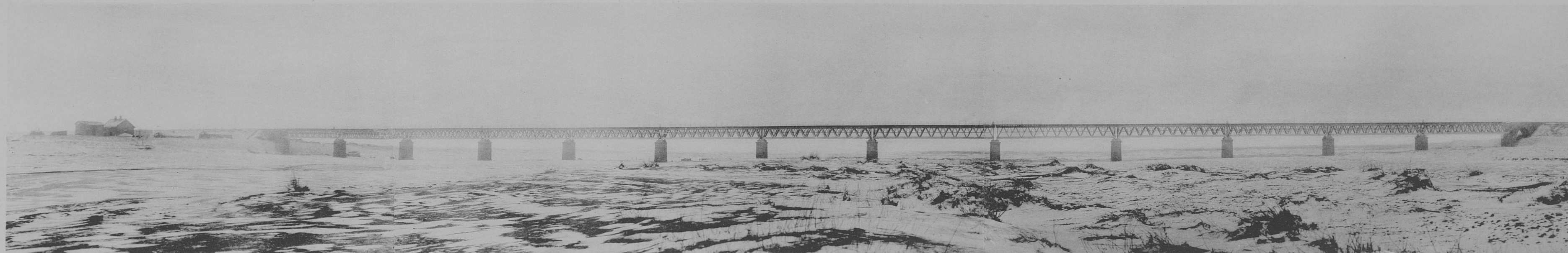
ОБЩИЙ ВИДЪ МОСТА ЧЕРЕЗЪ Р. ХУНЬХЕ, ОТВ. 345 СМЖ. (23×15.00) СЪ ЪЗДОЙ ПО ВЕРХУ. НА 515 ВЕР. ПИК. № 5121+13.69, ПРИ Н=5.18 СМЖ.
