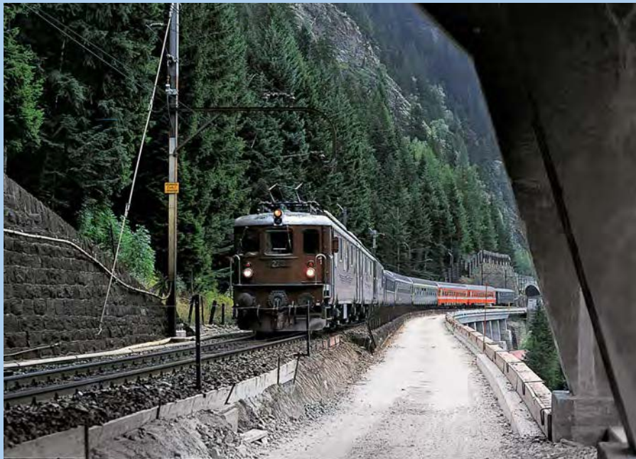
Bei der Schintigraben-Galerie unterhalb von Goppenstein diente der Betontrog für das zweite Gleis zunächst als Zufahrt zur Baustelle des neuen Mittelgraben-Tunnels (September 1987).
