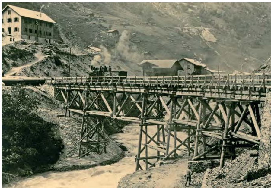
Provisorische Holzbrücke der Baubahn über den Fluss Lonza in Goppenstein (oben das Spital).
