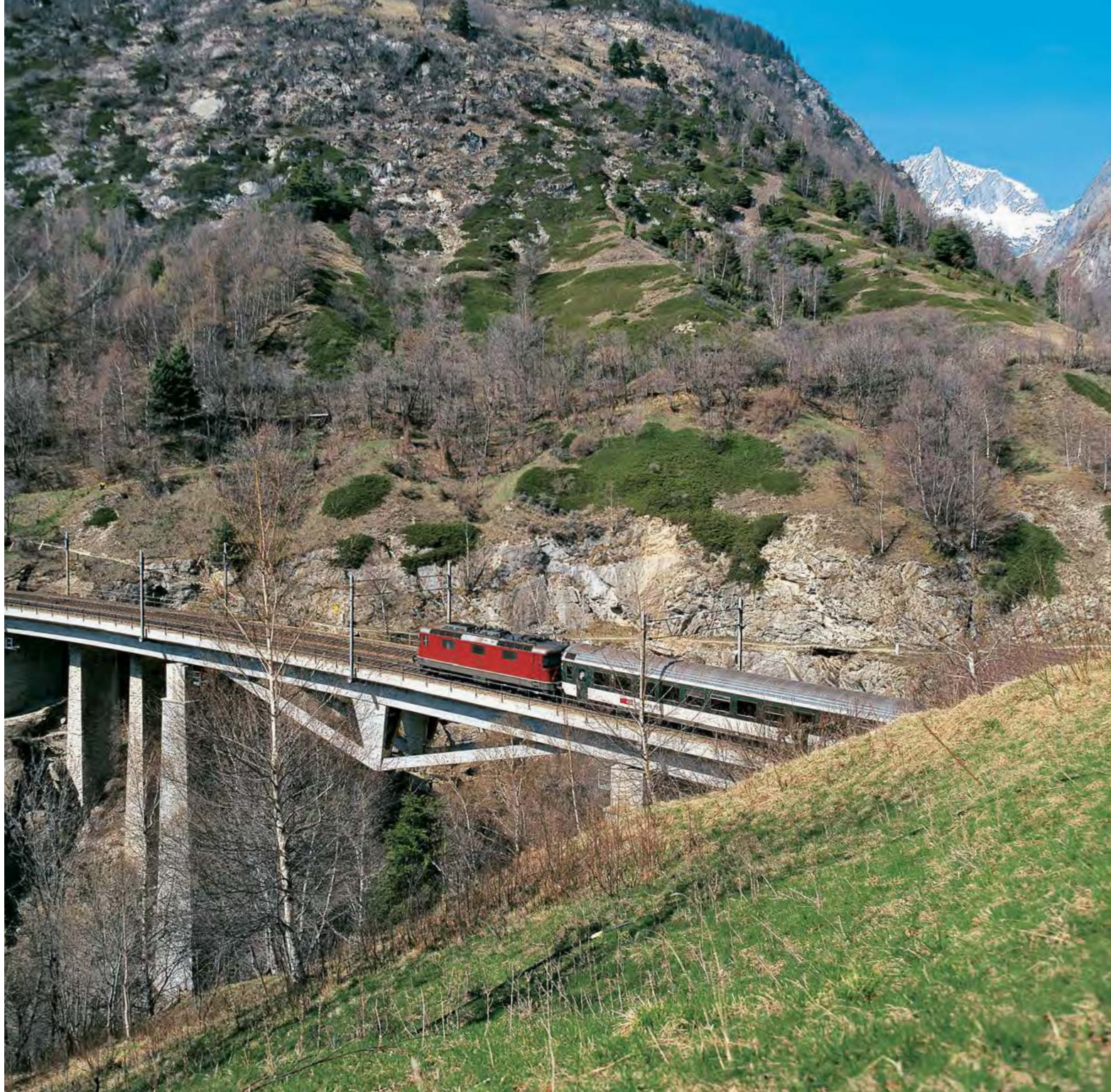
Baltschieder-Viadukt heute: Beim Doppelspurausbau wurde das Fischbauch-Fachwerk im Mittelteil entfernt und durch eine Betonkonstruktion mit Unterspannung ersetzt.
