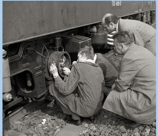
Das neu entwickelte Drehzapfenlager.
