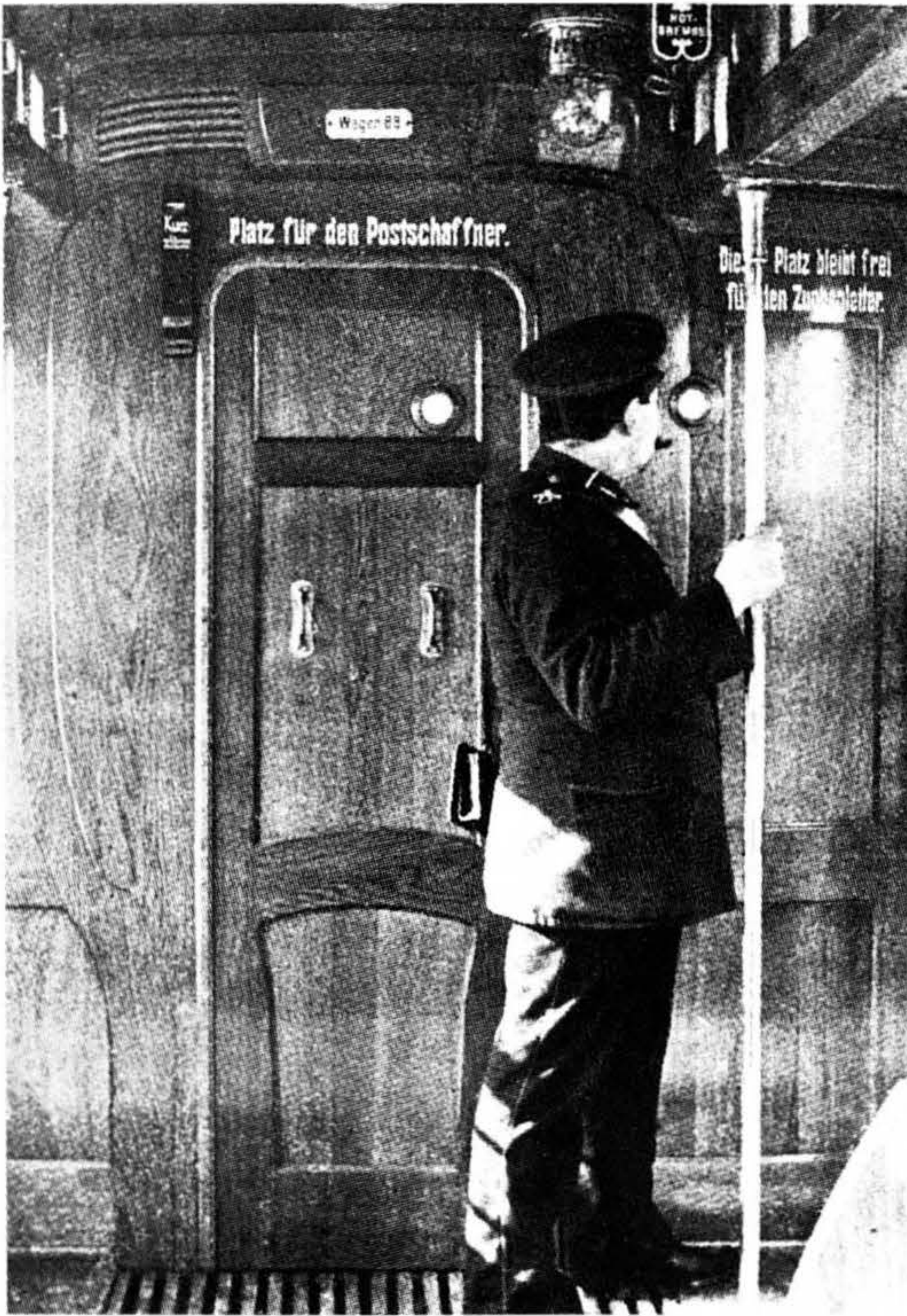
Bild 87 Der Zugbegleiter konnte durch ein Loch in der Wand die Strecke mitbeobachten und, falls der Triebwagenführer dienstunfähig wird, mit der Notbremse den Zug anhalten. Was aber, wenn der Zugbegleiter Fahrausweise kontrolliert? Nach dem Unfall am Gleisdreieck mußte der Zugbegleiter ständig die Strecke mitbeobachten.
