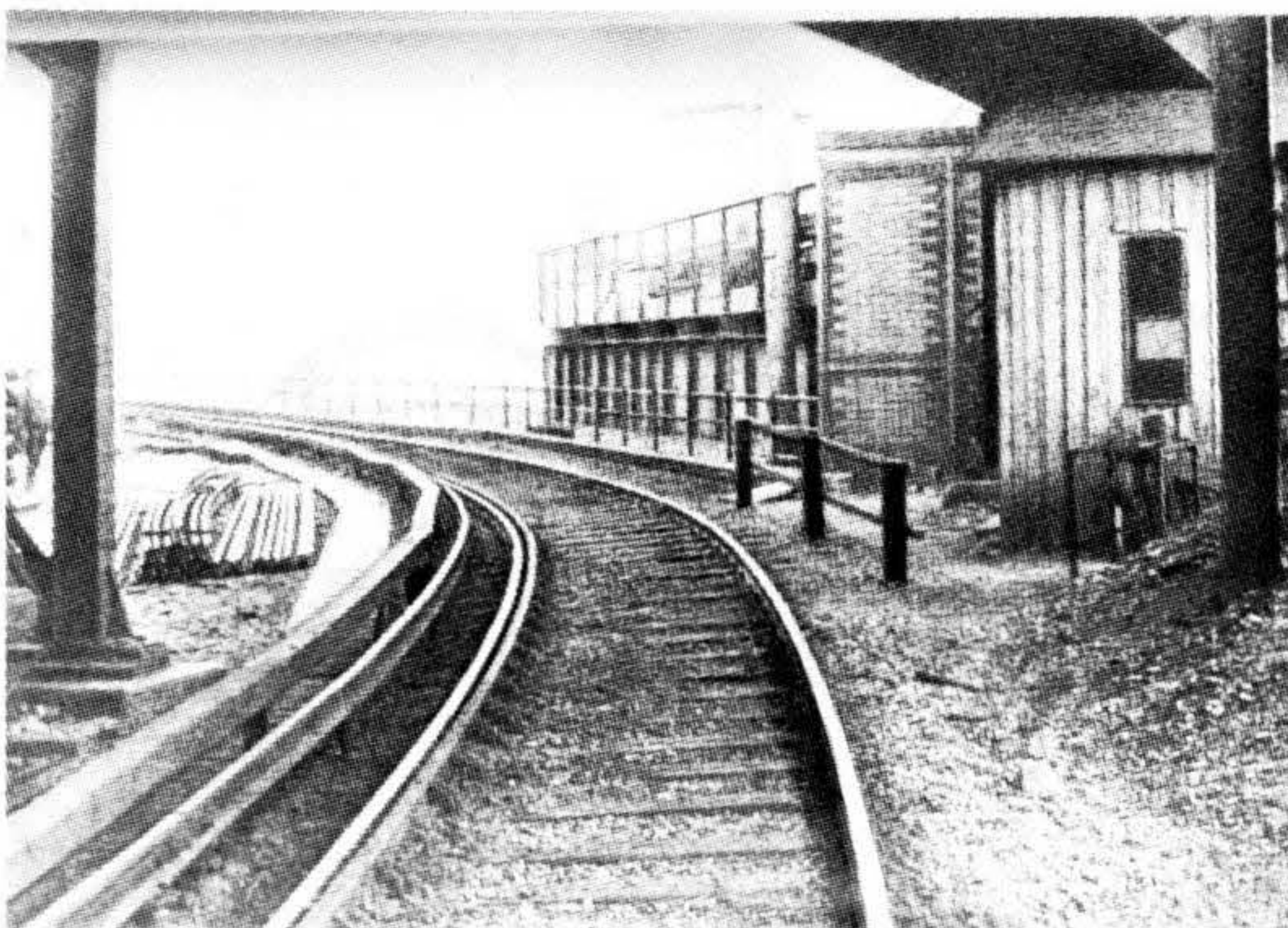
Bild 83 Vom Vorsignal L (im Bild rechts) kann das Blocksignal L nicht gesehen werden; hier ist der Zug 95 m vom Hauptsignal entfernt.
