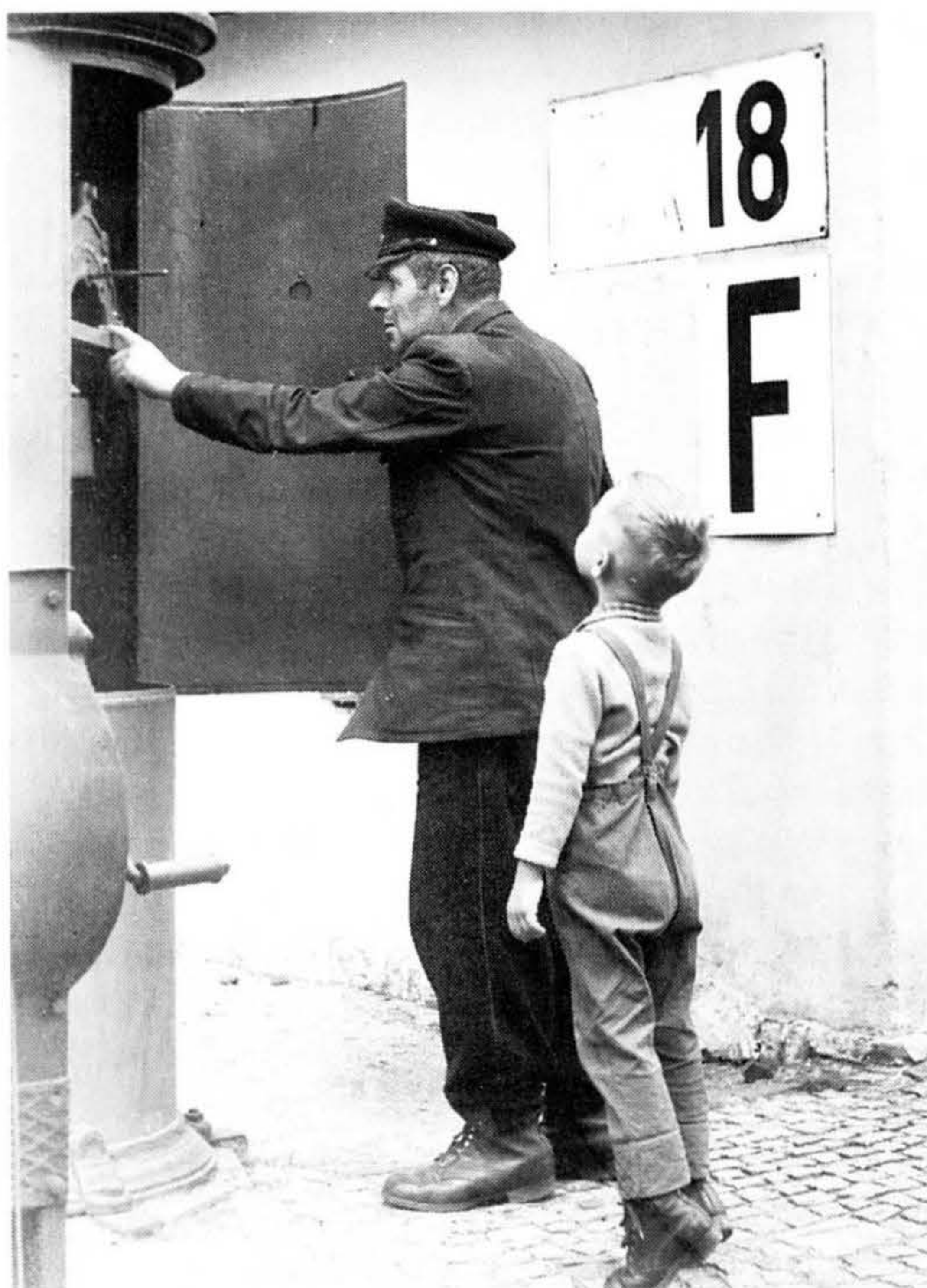
Bild 29 Das Läutewerk mußte ständig aufgezo- gen werden, sollte es seinem Zweck gerecht werden. Großvater erklärt es dem Enkel. (1958) Foto: Propp
