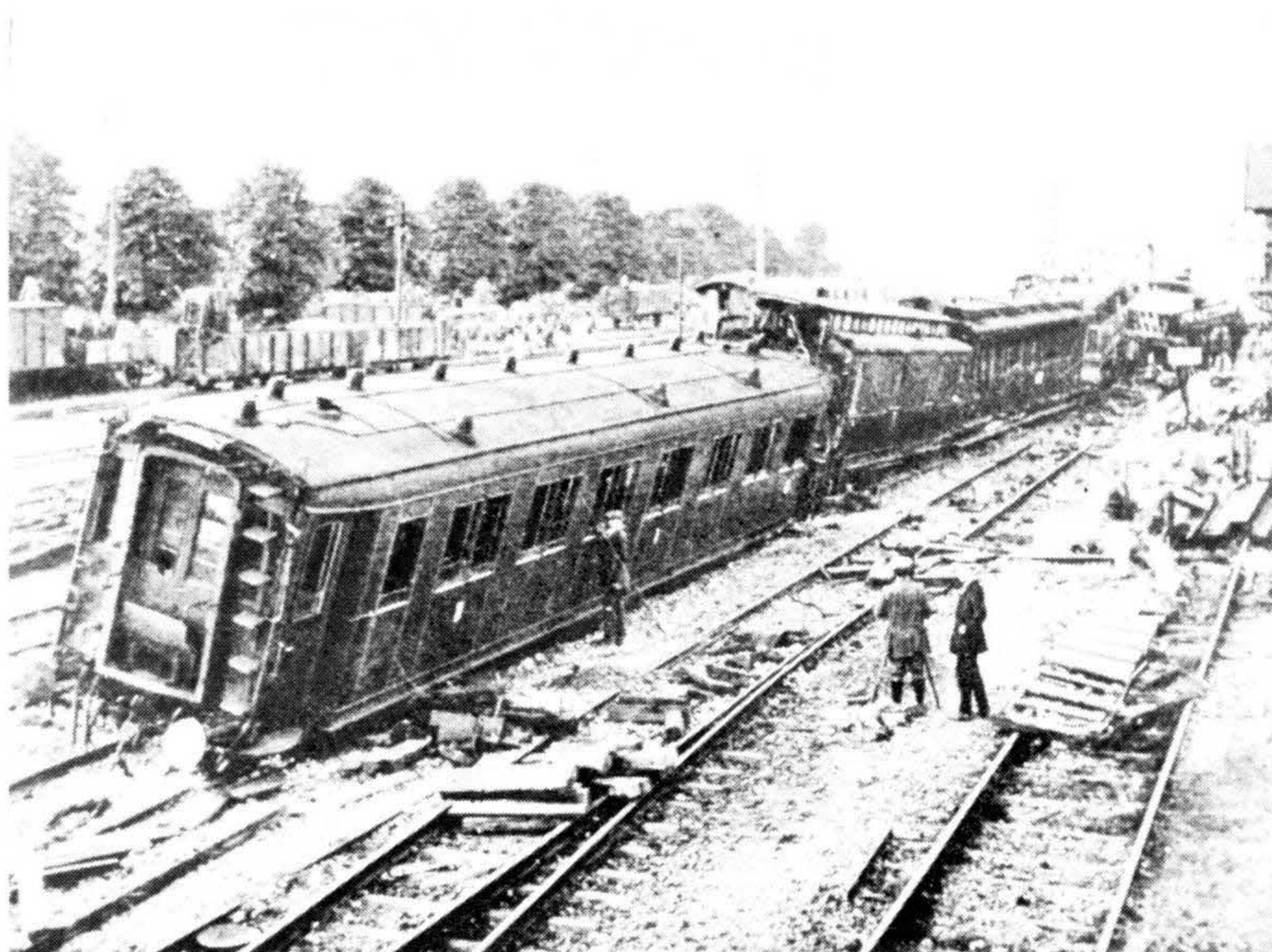
Bild 109 Entgleisung in Müllheim (Baden) am 17. Juli 1911. Der Lokomotivführer des D 9 war betrunken und fuhr an einer Baustelle zu schnell, statt – wie zugelas- sen – mit einer Geschwin- digkeit von 20 km/h mit 107 km/h! – 14 Tote, 32 Verletzte. Foto: Sammlung E. Preuß
