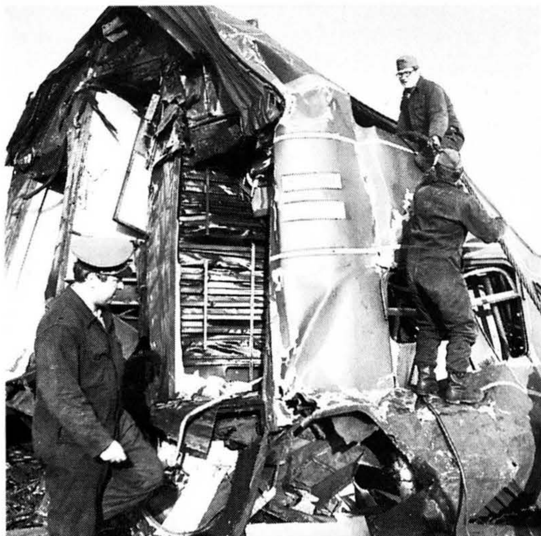
Bild 94 Beseitigung der Unfalltrümmer nach dem Zusammenstoß des Expreßtriebwagens Ext 69 »Karola« mit D 273 Aue–Berlin am 30. Oktober 1972, nachdem bei dichtem Nebel der Triebwagenführer auf dem Bahnhof Schweinsburg-Culten das Ausfahrersignal in Warnstellung und das Ausfahrersignal in Haltstellung nicht beachtet hatte. 25 Tote, 70 Verletzte.
