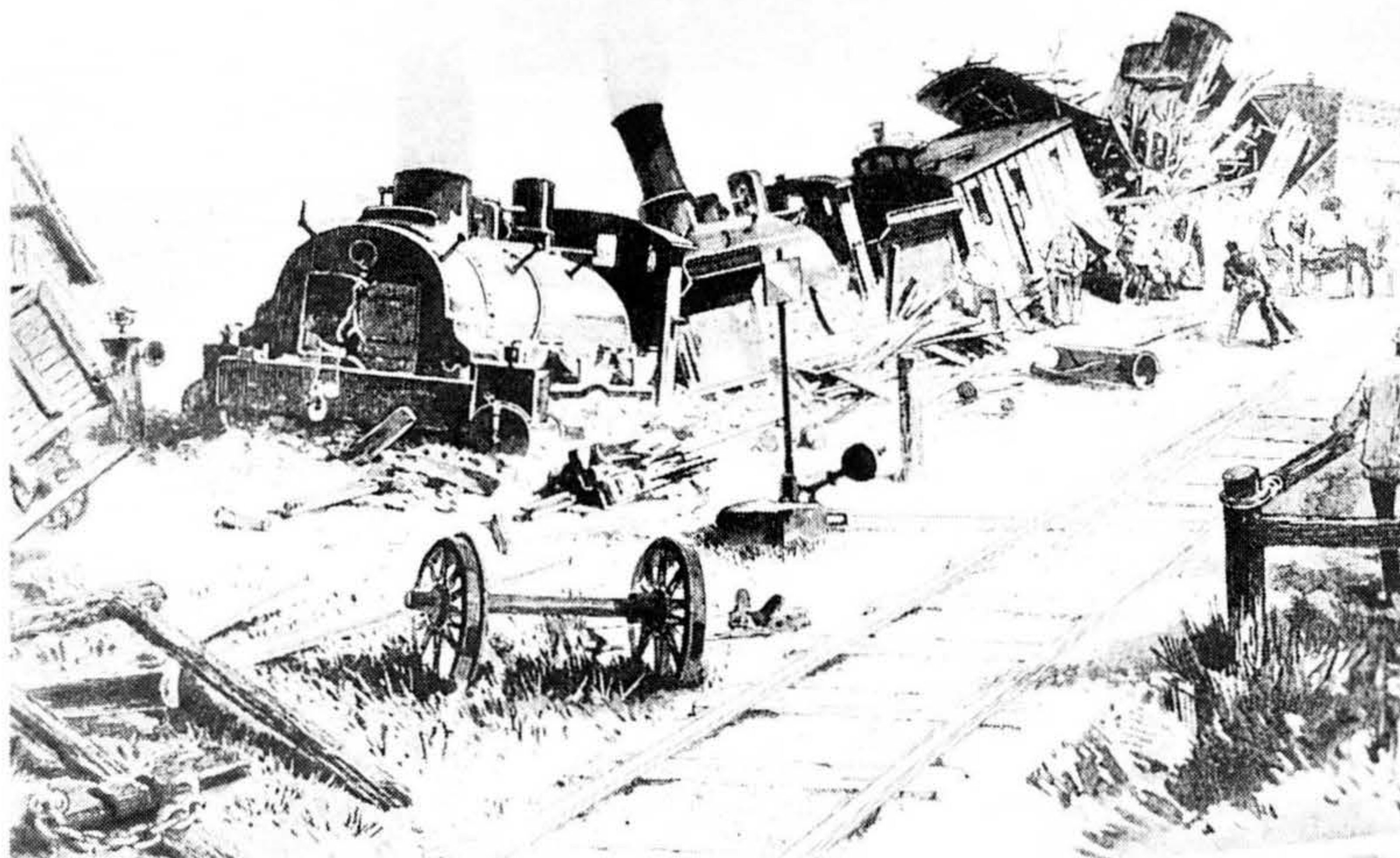
Bild 8 Entgleisung am 7. Juli 1889 in Röhrmoos. Der Weichen- wärter vergaß – bei primiti- ven Verhältnissen – eine Weiche zurückzustellen, und so fuhr der Schnellzug ins Stumpfgleis. Zehn Rei- sende wurden getötet. Quelle: Ritzau, Eisenbahn- Katastrophen in Deutsch- land
