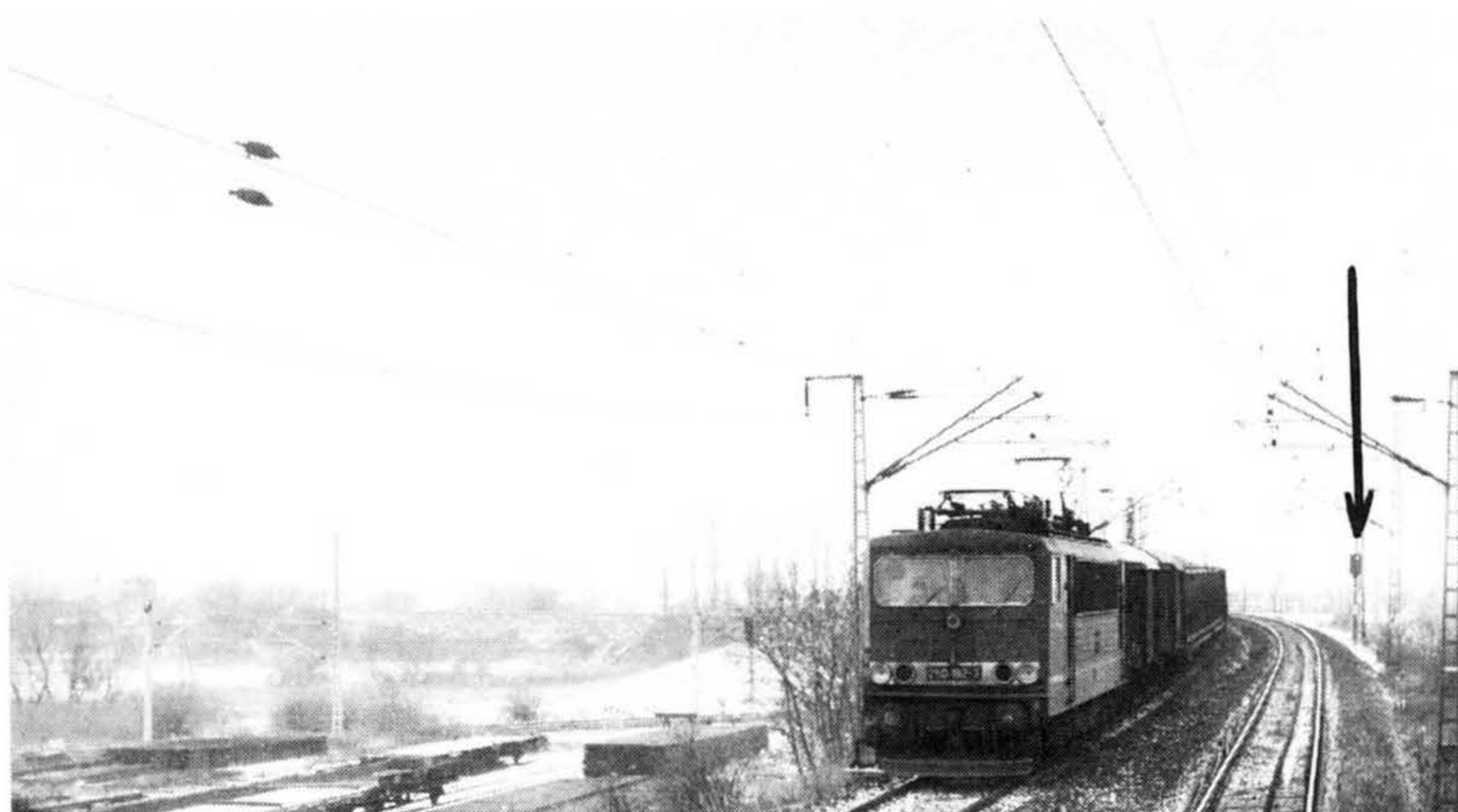
Bild 71 Wie der Lokomotivführer die Signale sieht: Blick vom Führerstand der Bau- reihe 243 (DR) auf den Vor- signalwiederholer zum Blocksignal Elbbrücke (Strecke Berlin–Halle). Foto: E. Preuß
