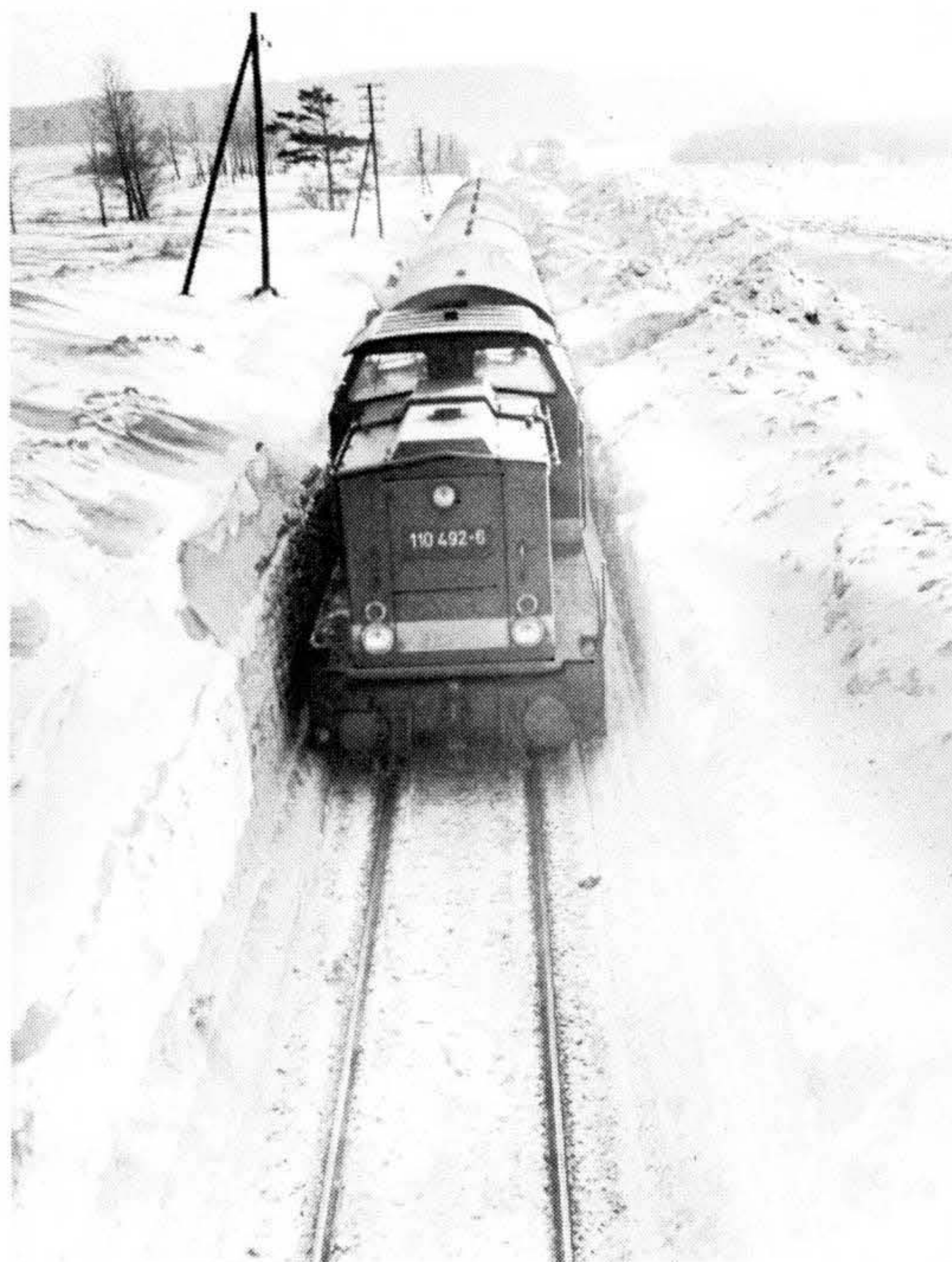
Bild 19 Diese Eiswand konnte nicht mehr durch Freischaufeln entstehen, sie mußte gesprengt werden. Im Januar 1979 zwischen Lietzow und Sagard. Foto: Krentzien
