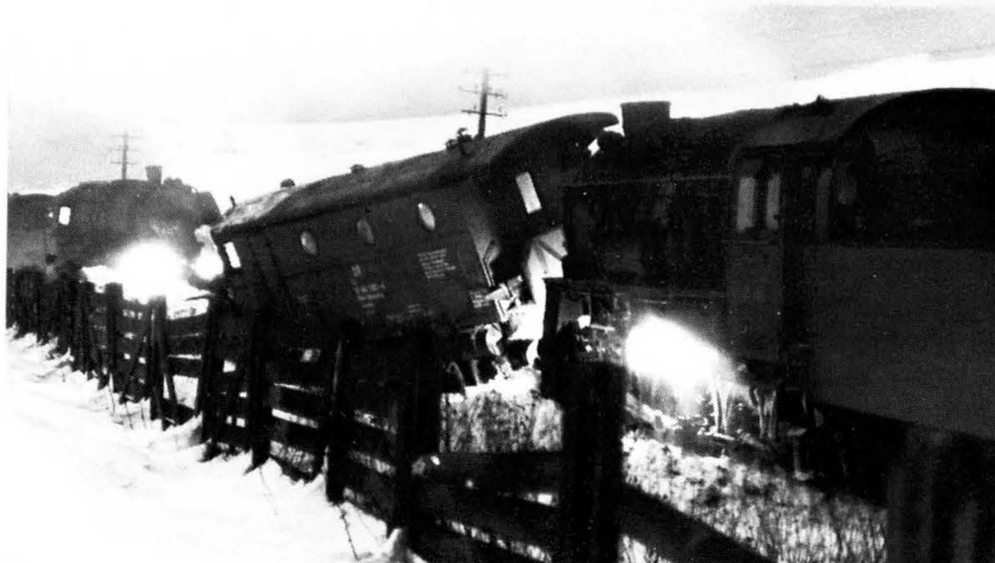
Bild 17 Schneepflüge neigen leicht zum Entgleisen, wenn, wie hier, am 10. Januar 1970 bei Zwönitz, der zusammengesobene Schnee wie eine Wand wirkt.
