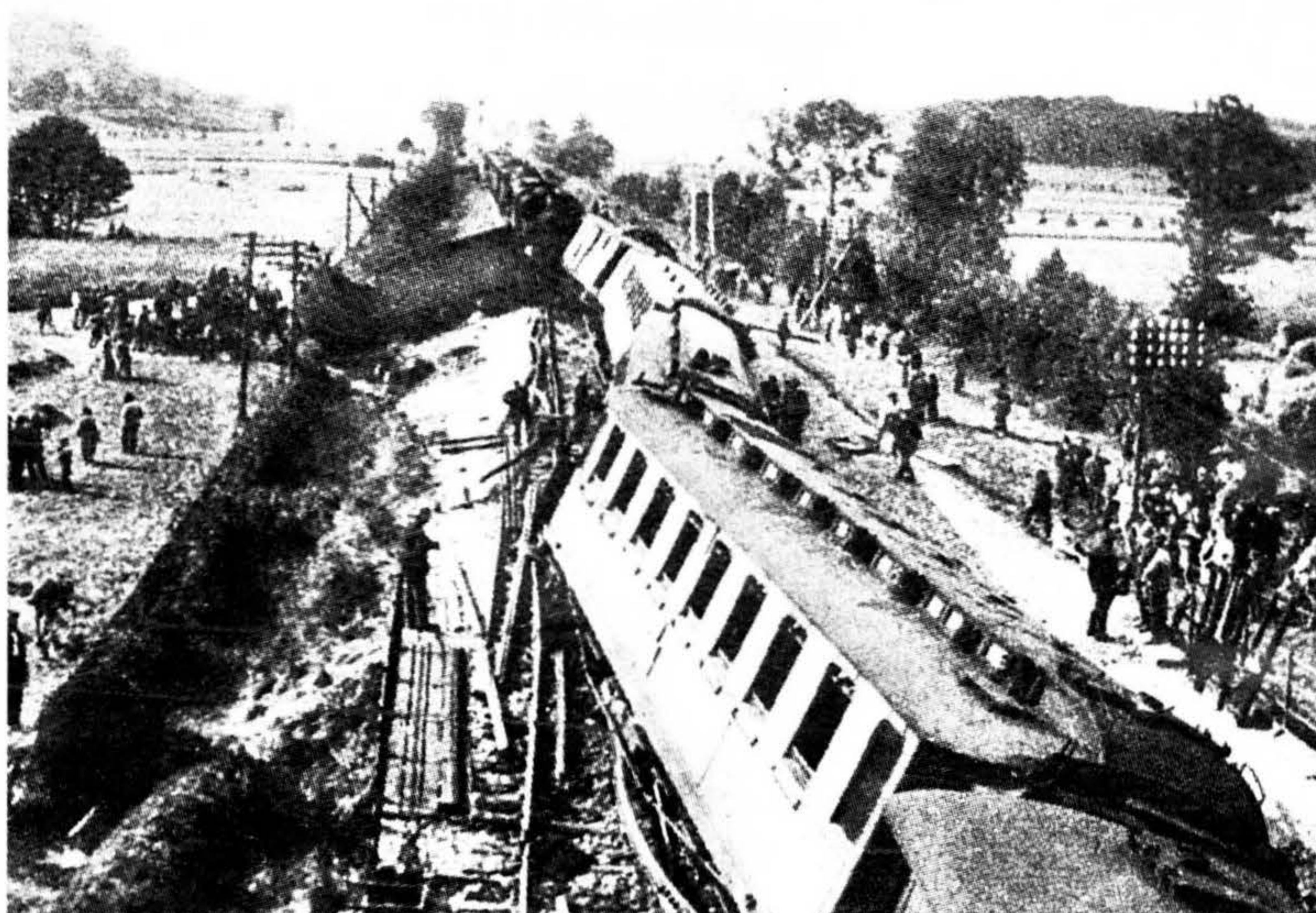
Bild 105 Entgleisung auf Bahnhof Ummendorf: Am 23. Juni 1928 fuhr D 135 zu schnell über eine ablenkende Weiche. 31 Verletzte. Foto: Sammlung E. Preuß
