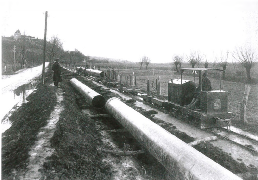
Kolej przy budowie wodociągu. Na czele lokomotywa Orenstein & Koppel typu R11a nr fabryczny 4160. Lata międzywojenne,
