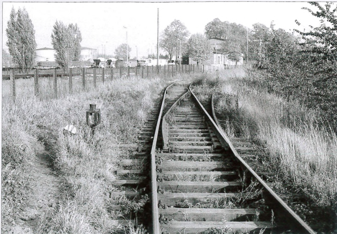
Rozjazd na wjeździe na stację niezdarnie wmontowany w łuk toru prowadzącego od strony Chelmy. 19.10.1992 r.
