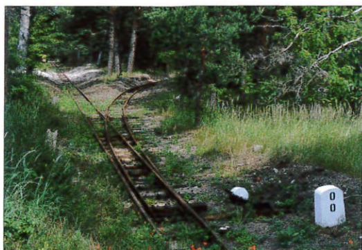
Rozjazd produkcji KRUPP 1943 przy odgałęzieniu toru do magazynów amunicji i środków bojowych. 29.06.2016 r. Fot. Paweł Jakuboszczak
