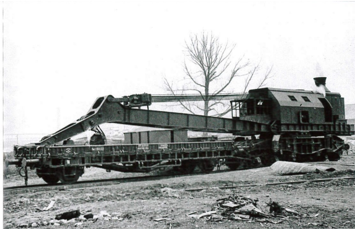
Żuraw kolejowy węgierskiej firmy RABA, typu PZ-45. Na wagonie platformie widoczne znaki kolei rosyjskich („СССР”).
