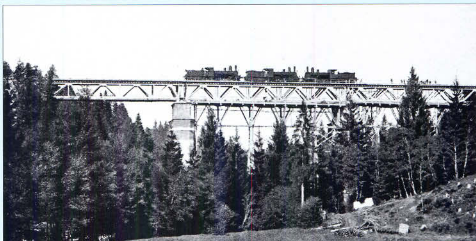
Bild 162: Drei Verbund-C IV bei einer Belastungsprobe der Brücke bei Maria Ort (Strecke Regensburg – Neumarkt/Opf.). Abb.: VM Nürnberg, Slg. Asmus
