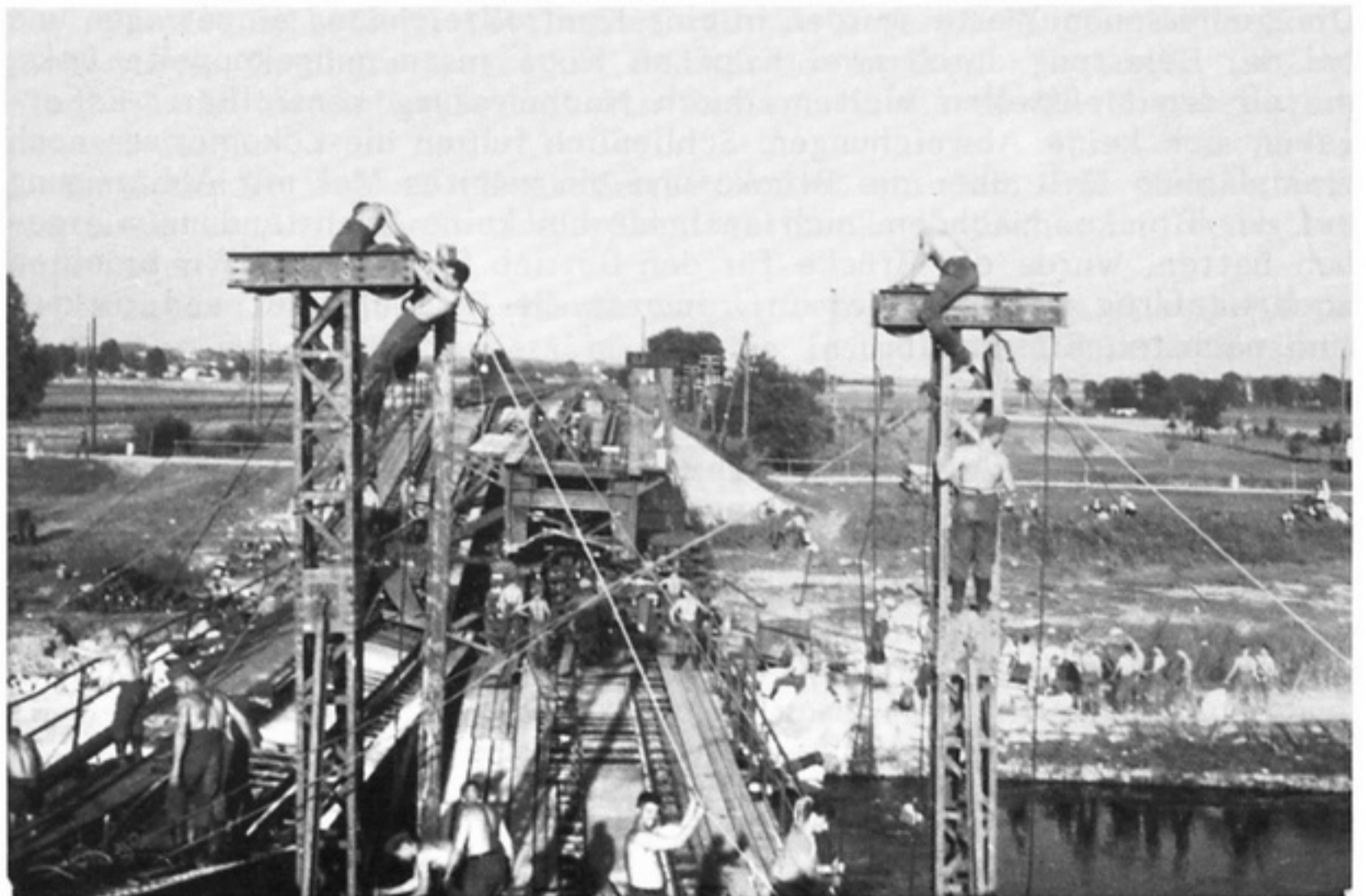
Olsabrücke bei Zawada/Freistadt: oben: Trümmerräumung / unten: Aufbau zweier Hebetürme <II>
