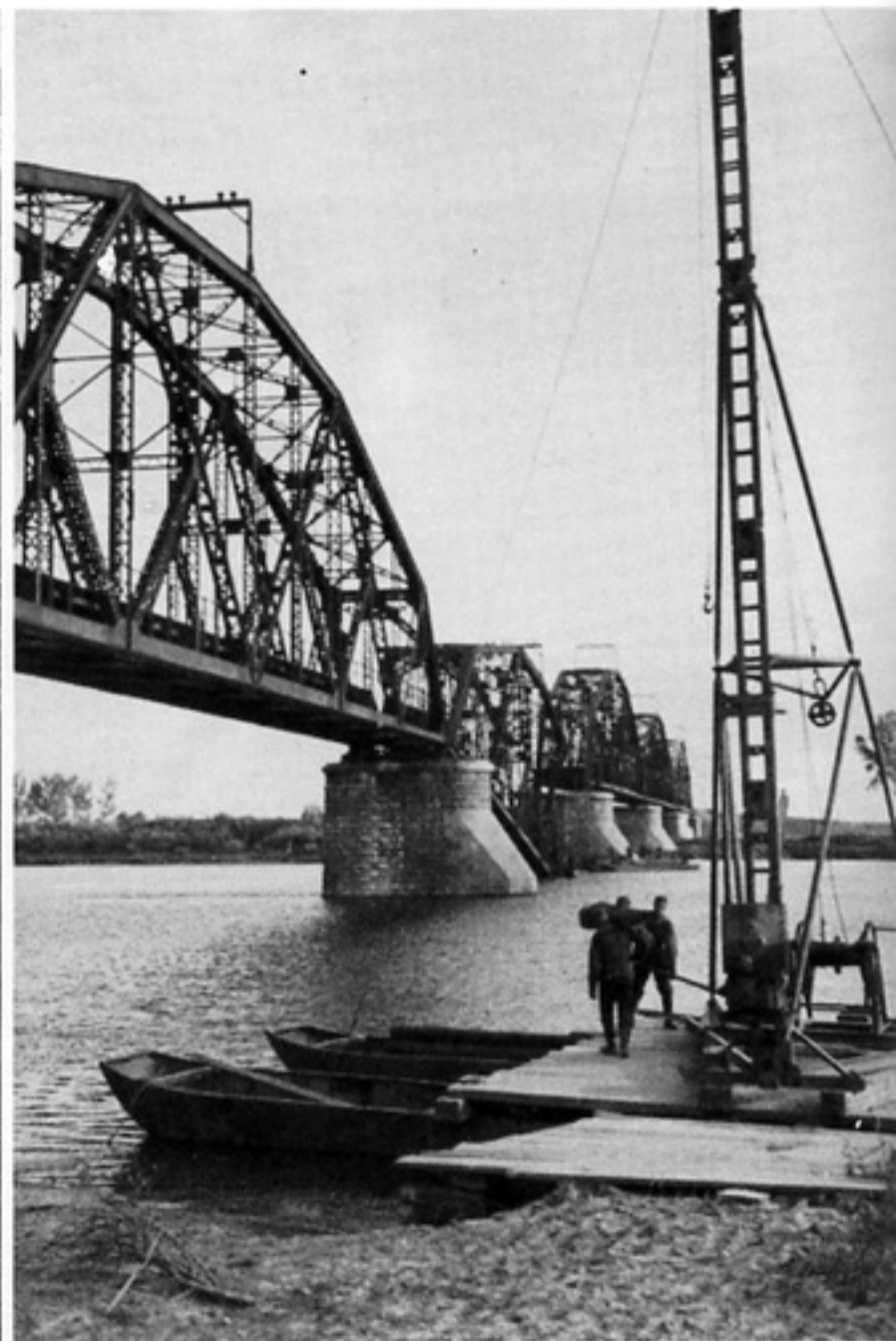
Aufbau des gesprengten Mittelbogens / Dieselramme DB 600 (=Bär) auf Fähre <II>
