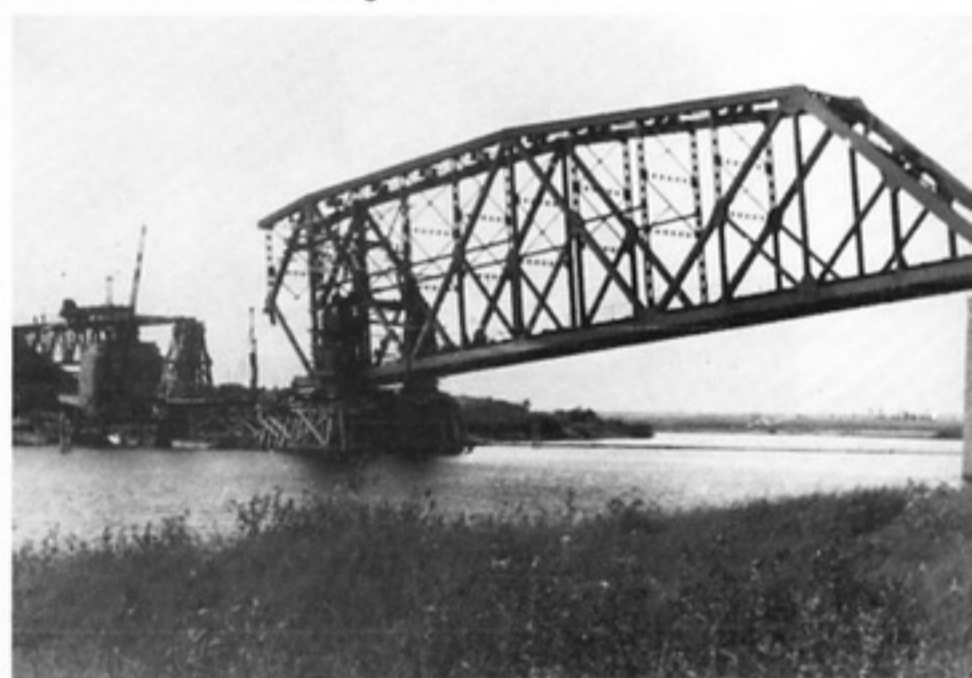
Mitte: Hebung und Zusammen- schließung der Brücke <II>
