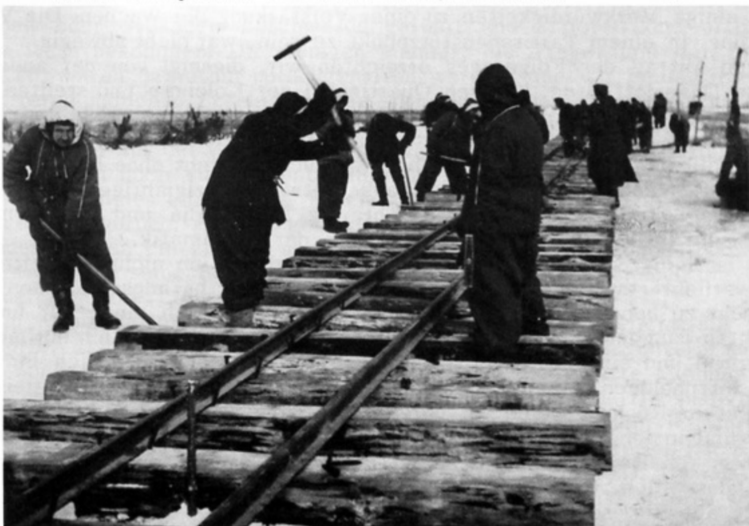
Feldbahnbau Strecke Utoschkino - Belebelka (südl. des Ilmensees); unten: Vernageln des Gleises auf Vollspurschwellen <II>
