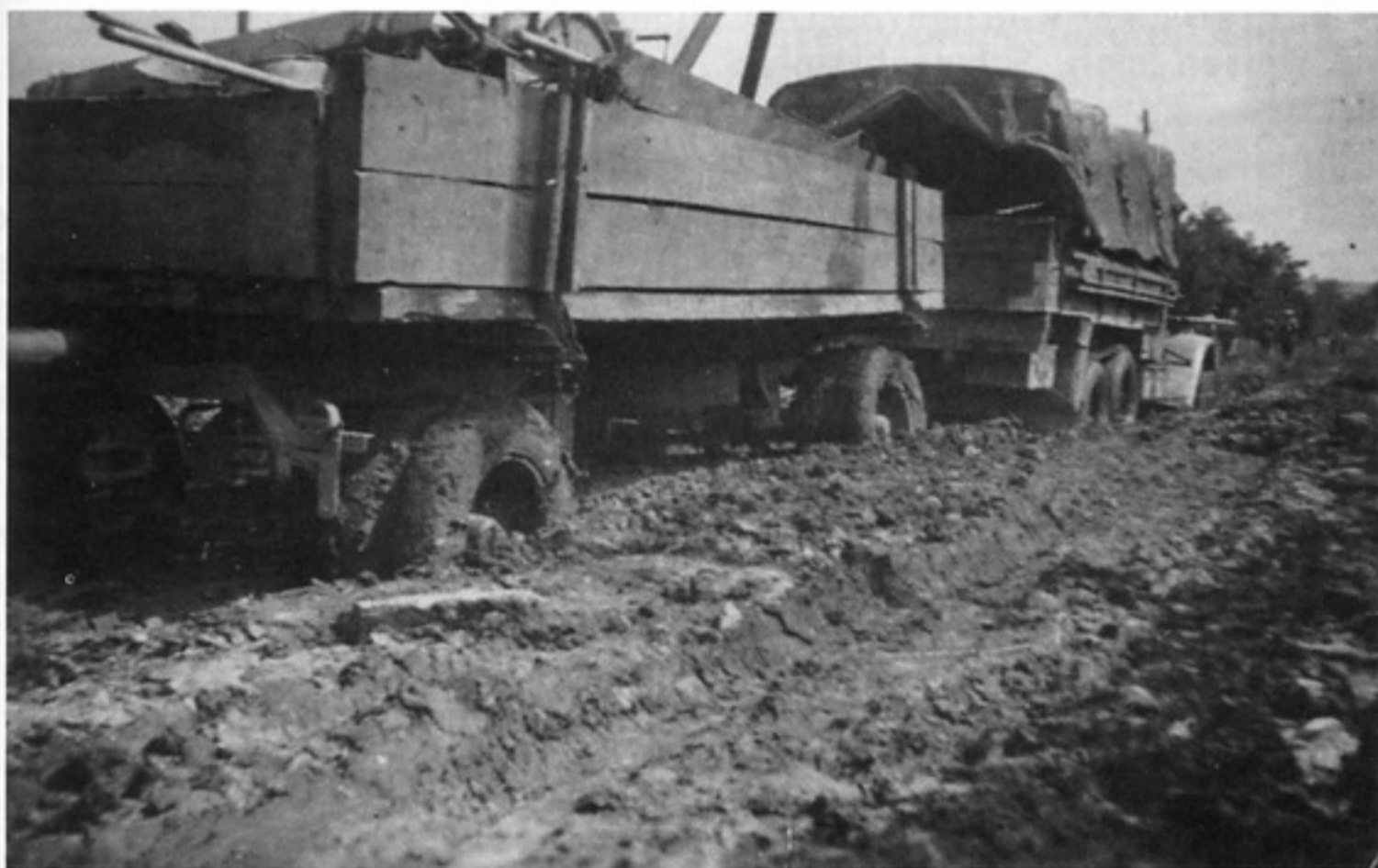
Rollbahnen (Sowjetstraßen) in den Schlammperioden. Tagesleistung: 3-5 km bei enormem Kraftstoffverbrauch und Materialverschleiß. <II>
