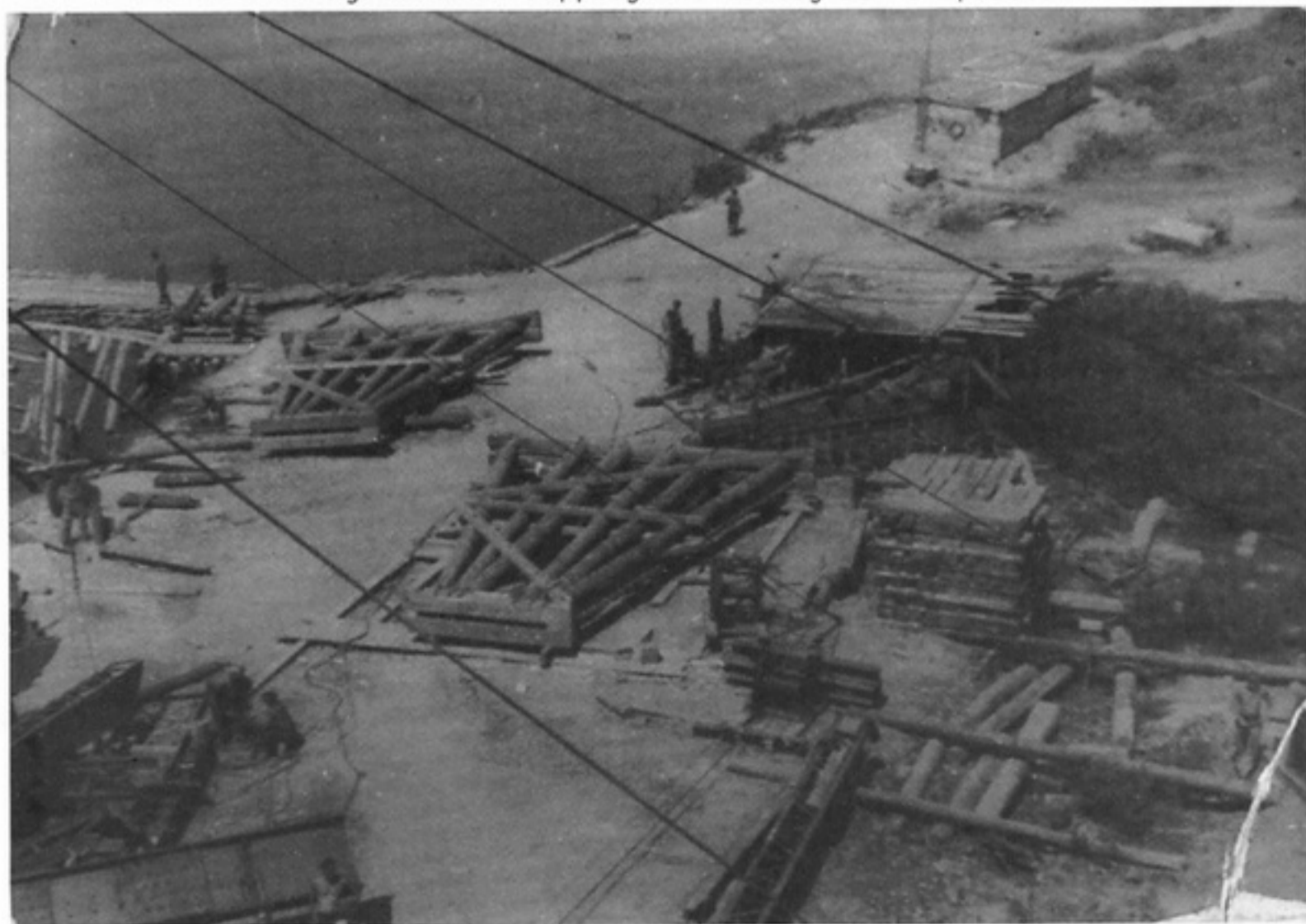
oben: Brückenfeld 2 ist gehoben, Brückenfeld 1 kommt zur Hebung unten: Die abgebundenen Doppeljoche fertig zum Stapellauf <II>
