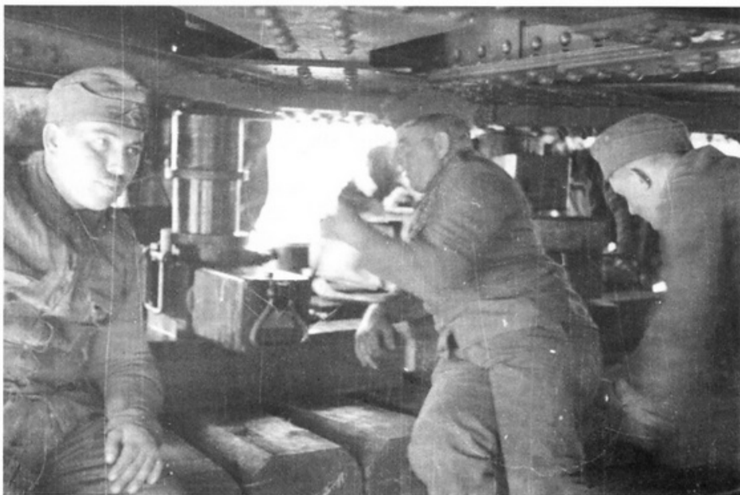
Pressen dieser Größe hatten wir nicht. Wir mußten daher mehrere ansetzen. <II>
