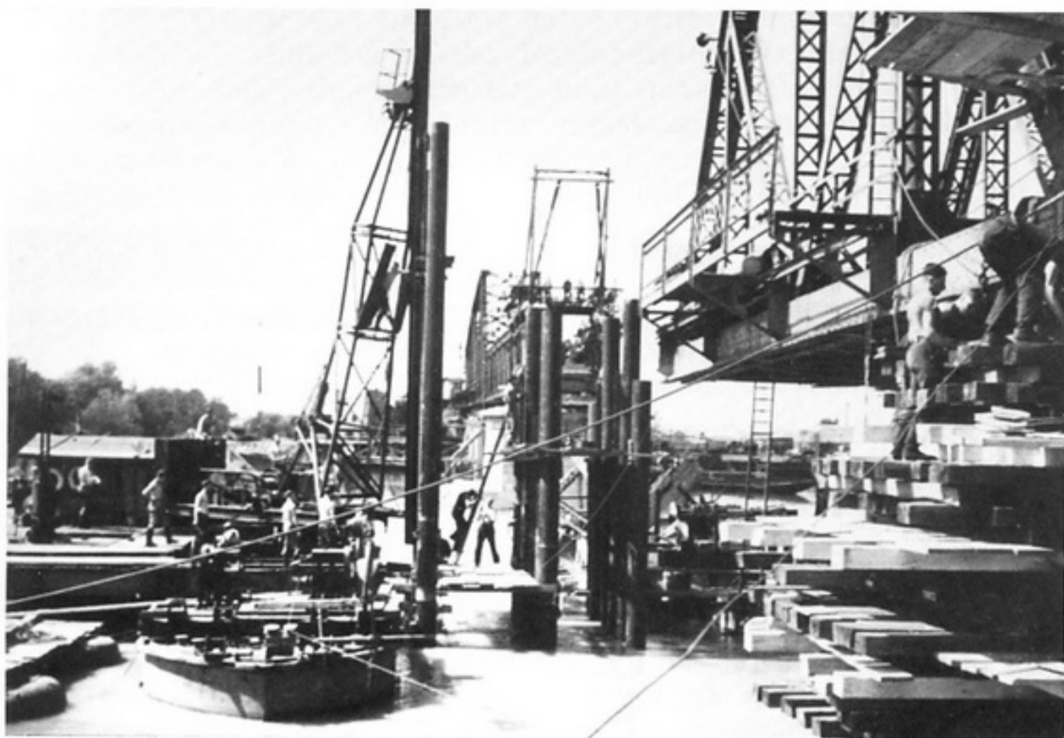
oben: Nach Hebung des zweiten Brückenteiles rammt das Pfeilergründungs- gerät das Joch aus Stahlpfählen // unten: Sicht unter das gehobene zweite Feld mit seitlichen Stahlrohrjochen, rechts bereits abgebunden.- <II>
