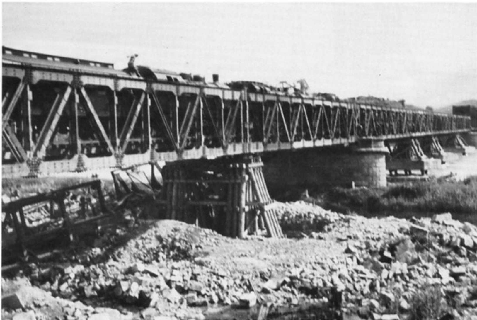
oben: Belastungsprobe vom Westufer gesehen unten: Gesamtansicht der fertigen Brücke von Osten <II>
