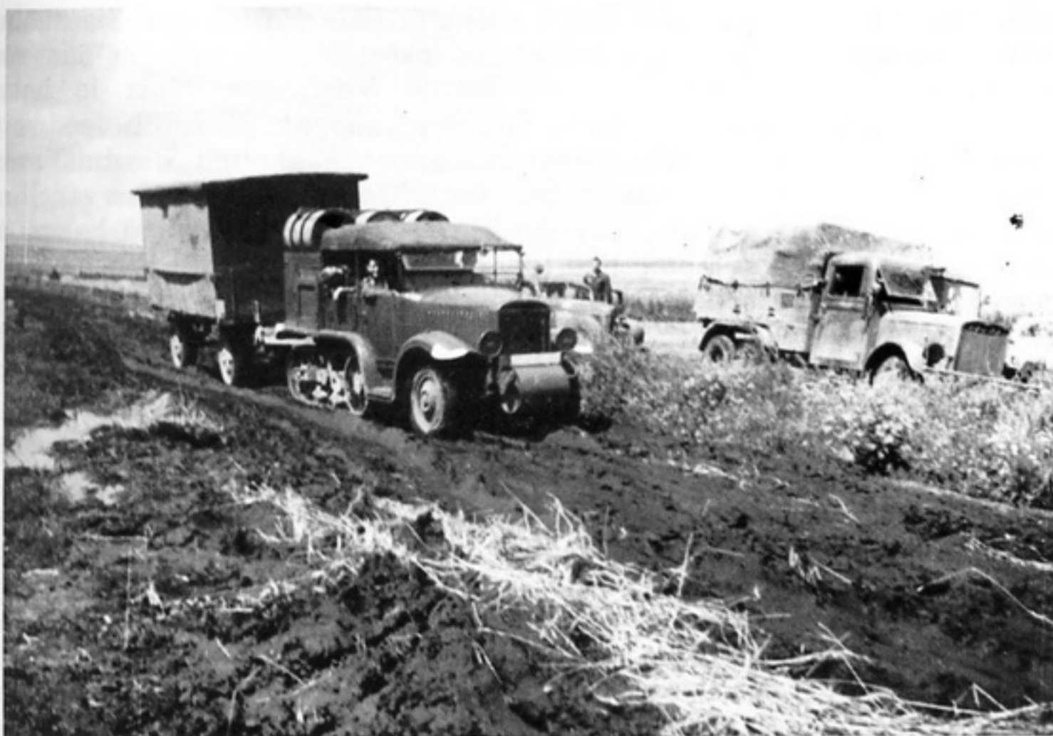
Rollbahnen (Sowjetstraßen) in den Schlammperioden. Tagesleistung: 3-5 km bei enormem Kraftstoffverbrauch und Materialverschleiß. <II>
