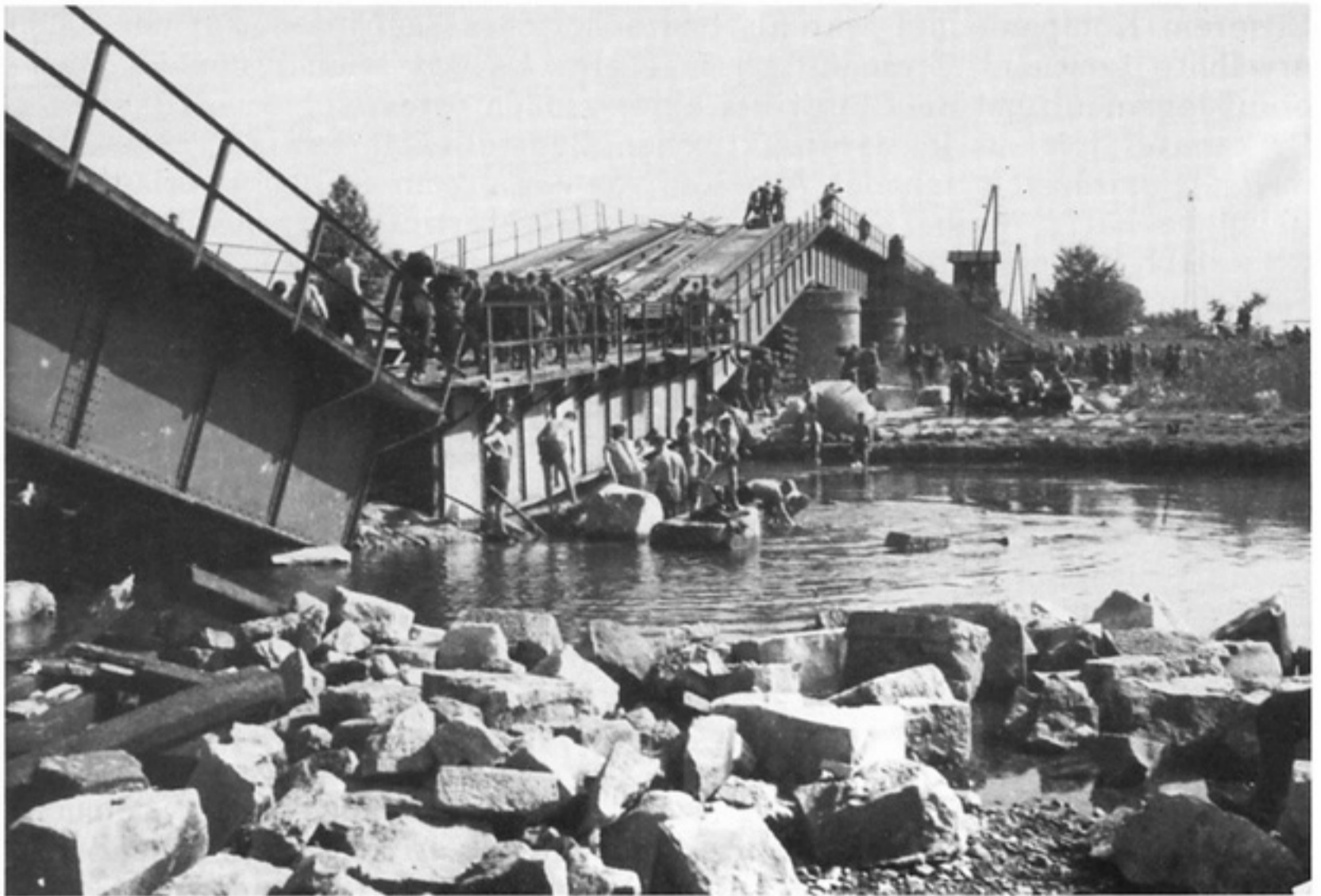
Olsabrücke bei Zawada/Freistadt: oben: Trümmerräumung / unten: Aufbau zweier Hebetürme <II>
