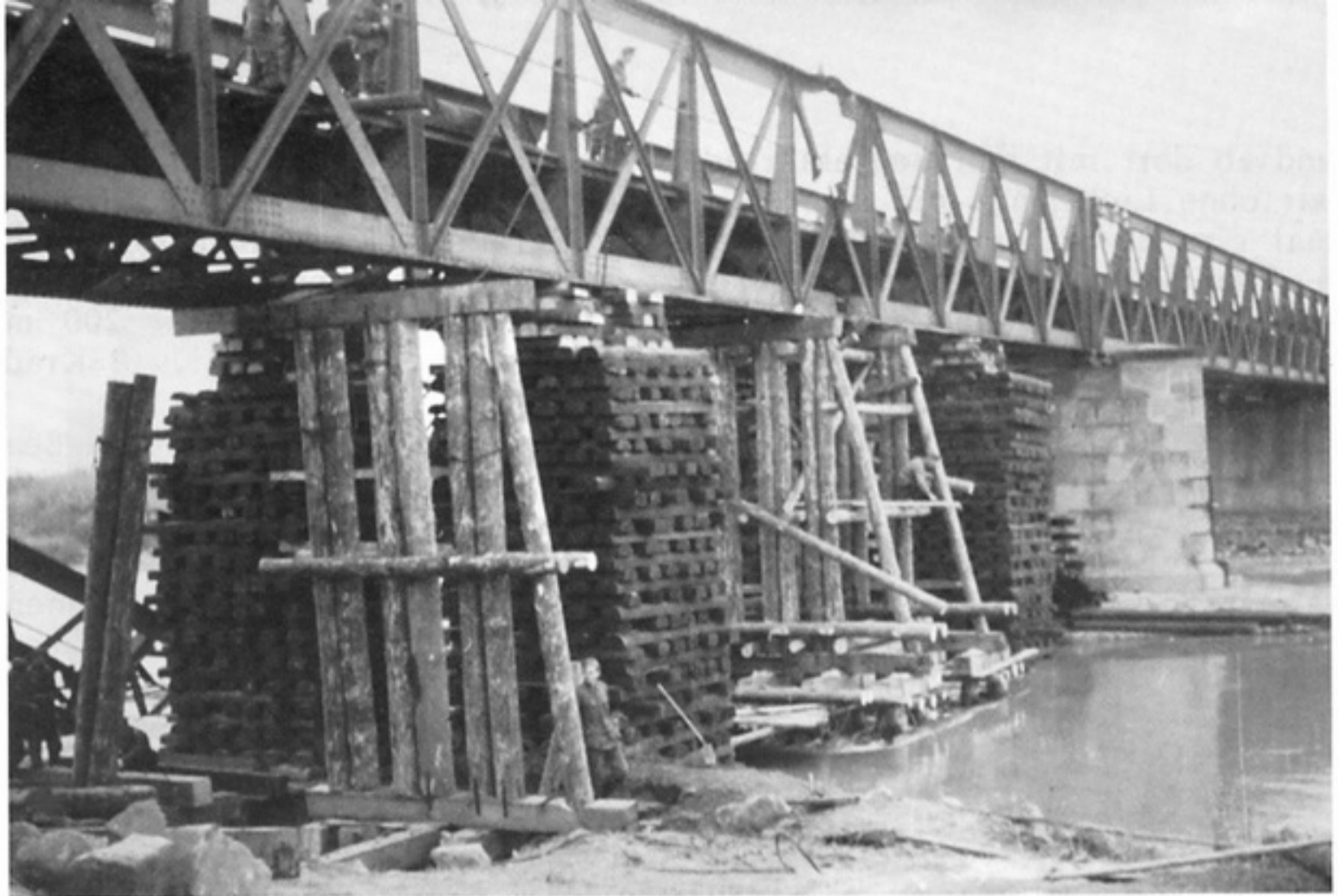
Die Dunajecbrücke westl. Tarnow. Da die Brücke nur angesprengt war, wurde sie auf Schwellenstapel angehoben, ausgeglichen und dann auf gerammte Joche abgesenkt. <II>
