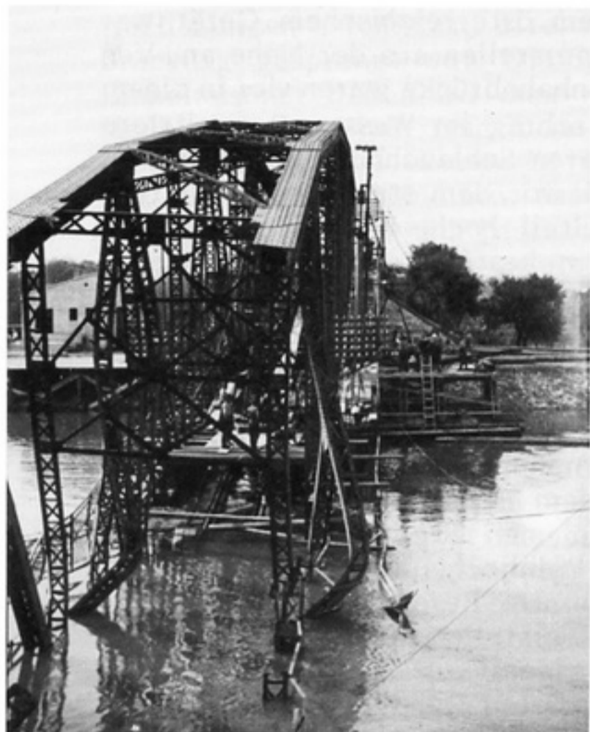
Arbeiten an der Savebrücke - oben li.: Das abgestürzte Tragwerk des ersten Brückenfeldes ist zur Hebung vorbereitet / re.: Vorbauspitze des S.Z.=Gerätes mit mechanischem Kranaufbau // unten: Gehobenes erstes Brückenteil auf Schwellenstapel mit Leergerüst für Roth=Wagner=Brückengerät.- <II>
