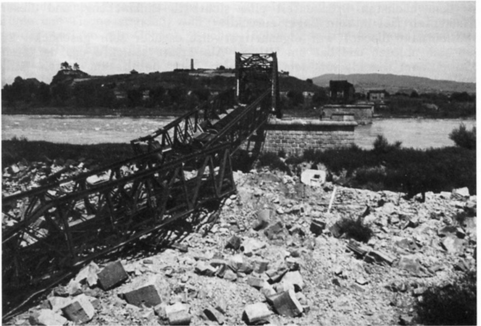
Die zerstörte Rheinbrücke bei Breisach von Westen gesehen (oben) unten: Dampfkranne (vorn); Abbinden der Ramppfähle, dahinter Ein- schalen und Ausbetonieren des Pfahljochs als Eisbrecher <II>
