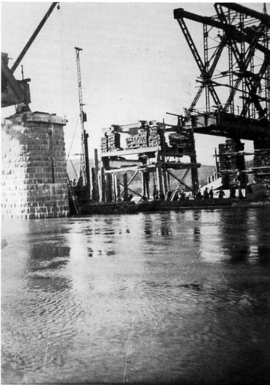
Aufbau des gesprengten Mittelbogens / Dieselramme DB 600 (=Bär) auf Fähre <II>
