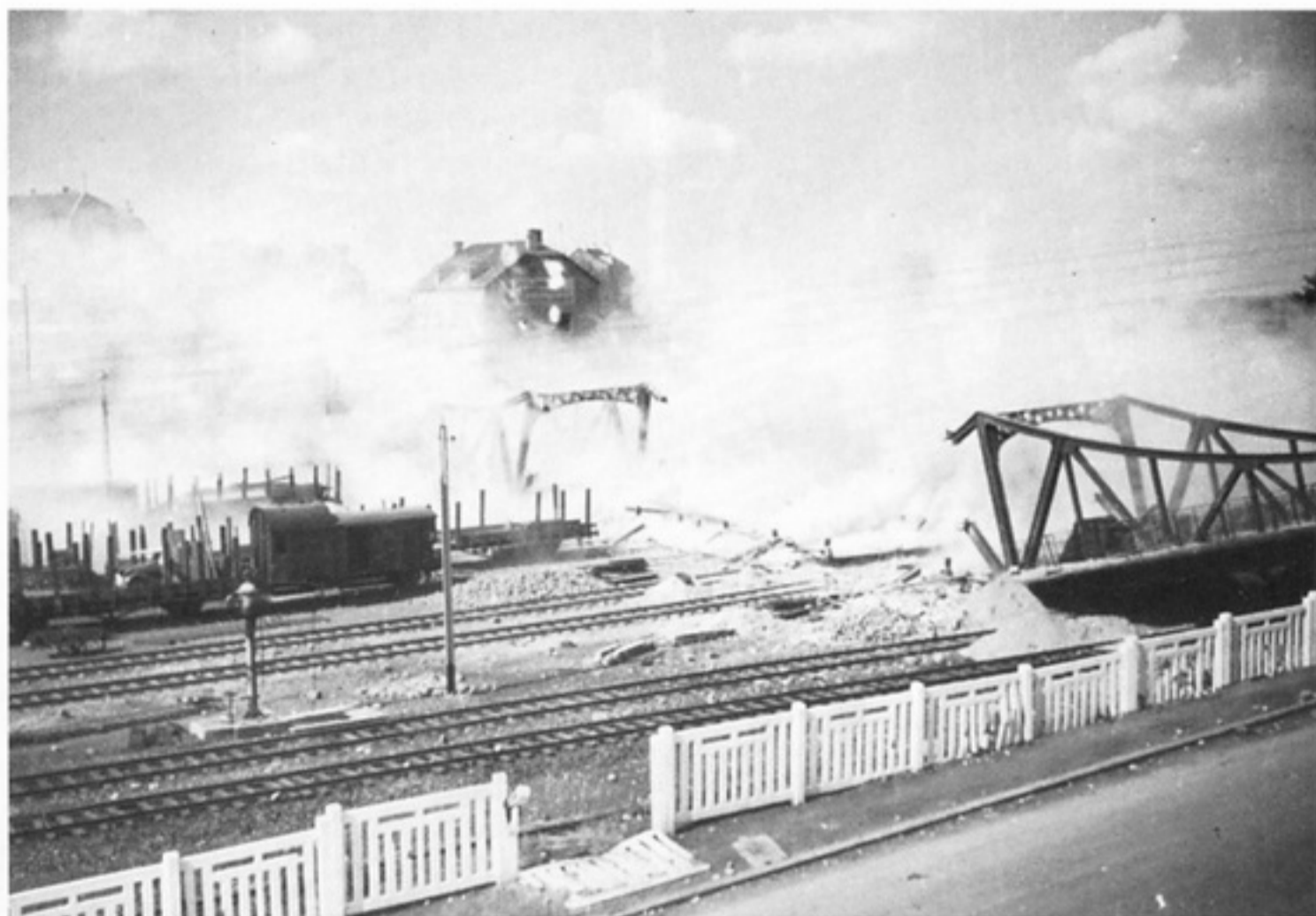
Einsätze in und um Libramont - oben: Beseitigung der Trümmer einer die Schienen blockierenden Straßenbrücke - unten: Zwei Gleise sind wieder frei.- <II>
