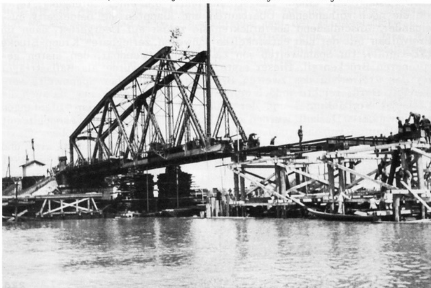
Arbeiten an der Savebrücke - oben li.: Das abgestürzte Tragwerk des ersten Brückenfeldes ist zur Hebung vorbereitet / re.: Vorbauspitze des S.Z.=Gerätes mit mechanischem Kranaufbau // unten: Gehobenes erstes Brückenteil auf Schwellenstapel mit Leergerüst für Roth=Wagner=Brückengerät.- <II>
