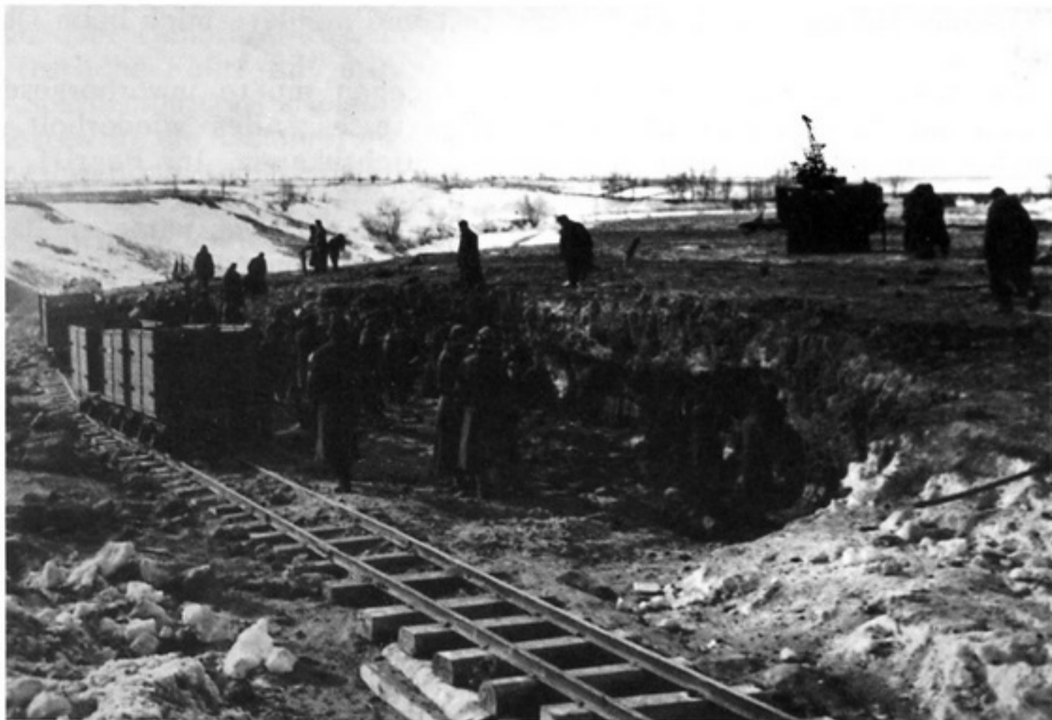
Feldbahnbau Strecke Utoschkino - Belebelka (südl. des Ilmensees); unten: Vernageln des Gleises auf Vollspurschwellen <II>
