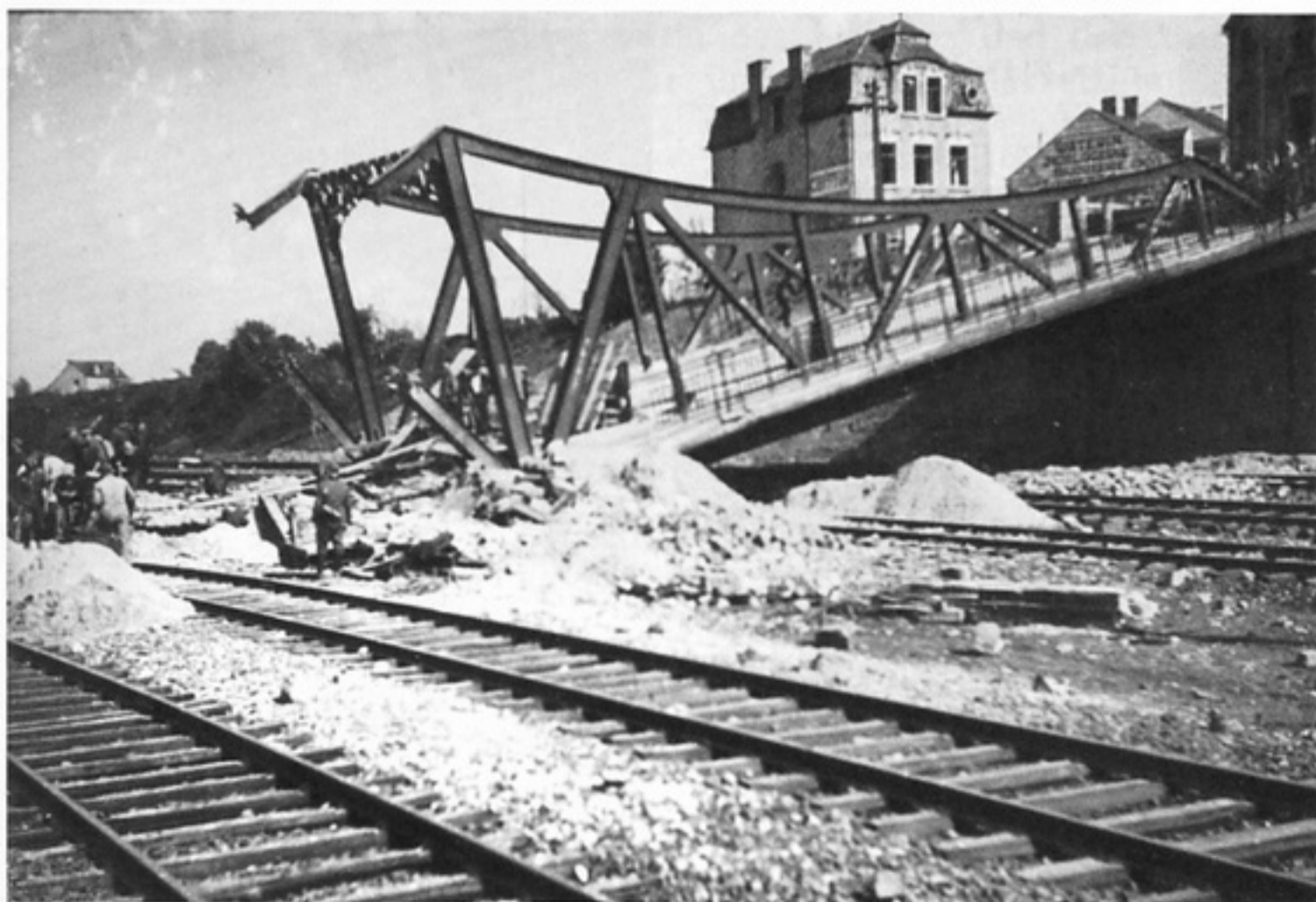
Einsätze in und um Libramont - oben: Beseitigung der Trümmer einer die Schienen blockierenden Straßenbrücke - unten: Zwei Gleise sind wieder frei.- <II>
