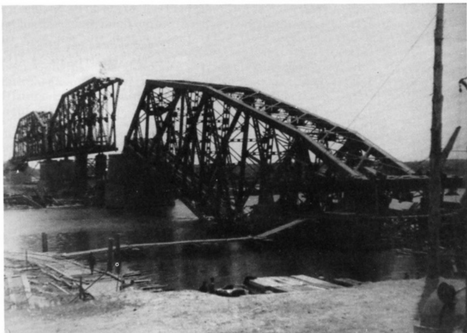
oben: Brückenfeld 2 ist gehoben, Brückenfeld 1 kommt zur Hebung unten: Die abgebundenen Doppeljoche fertig zum Stapellauf <II>
