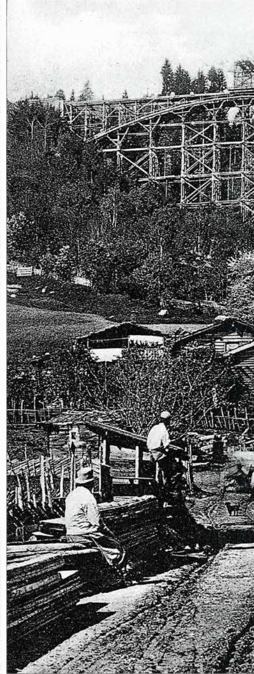
Bild 11: Die Kennlach-Brücke kurz nach der Eröffnung der Tauernbahn; man erkennt die gerade Gitterbrücke mit dem gebogenen Gleis. Diese Konstruktion ist bis heute erhalten. Abb.: Sammlung Zopf
