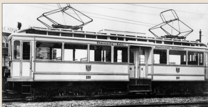
Mitteleinstiegs-Vierachser der Fernbahn Düsseldorf – Krefeld von 1912. Sie waren mehr Eisenbahnwagen als Straßenbahnen und gingen baulich auf Fahrzeuge für die Köln-Bonner Eisenbahnen zurück
