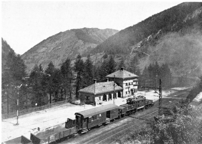
Reihe 1100 mit Güterzug im Bhf. Brennersee (etwa 1933). Brennersee war zu dieser Zeit ein eigens ausgebauter Bahnhof für den Traktionswechsel, da bis 1934 zwischen Brennersee und Brenner noch mit Dampflokomotiven gefahren werden mußte.
