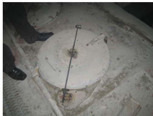
Рис. 6. Запорное устройство для каждого загрузочного люка
