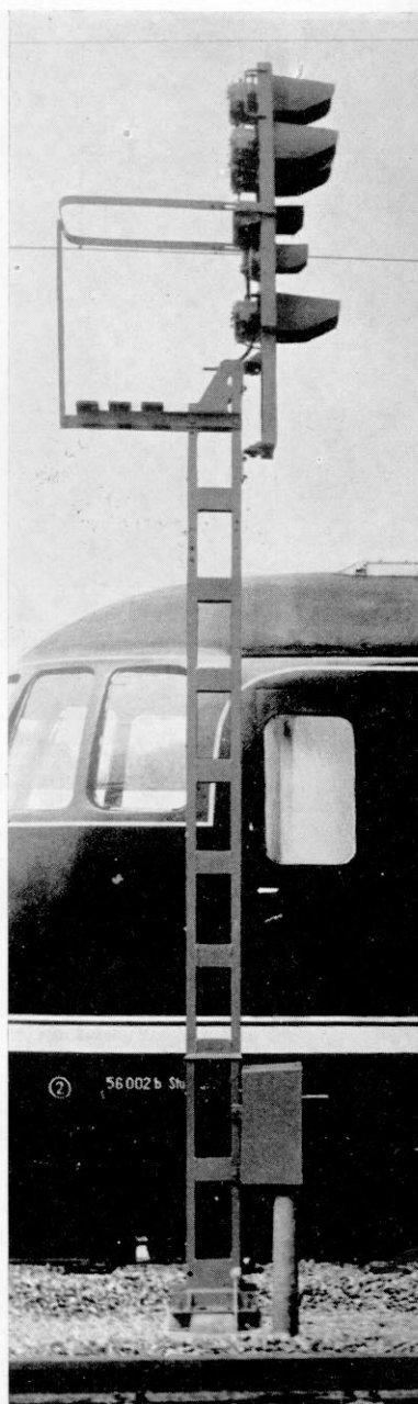
Abb. 6 und 7. Rück- und Seitenansicht eines gleichen Ausfahrt-Lichtsignals (auf der DVA Mün- chen) in fast genauer 0-Größe!
