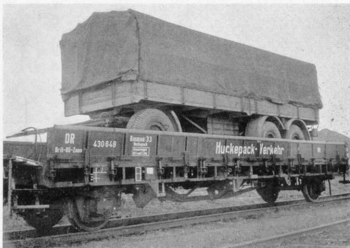
Ein „Huckepack“-fahrender Lastkraftwagen auf einem der für diesen Dienst speziell hergerichteten Rmso-33 Wagen. Foto: Palm, Ffm.
