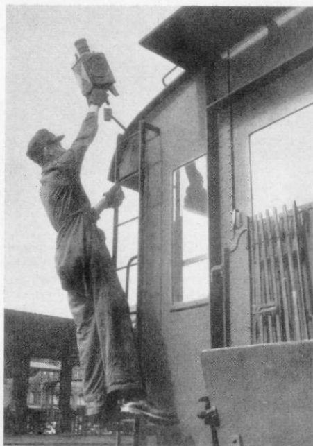
Abb. 1. Ohne die Zugschlußsignale (Laternen bzw. Scheiben) darf kein Zug über die Strecke fahren. In jedem Ausgangsbahnhof sorgen deshalb Bahnbeamte dafür, daß jeder Zug damit ausgerüstet ist.
