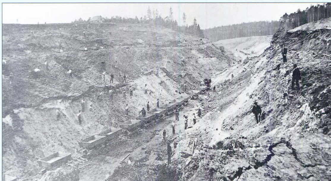
Bild 143: So wurden damals Eisenbahnstrecken gebaut: Bei Parsberg entstehen Damm und Unterführung im Zuge der Linie Nürnberg – Neumarkt – Regensburg. Foto: Verkehrsmuseum Nürnberg
