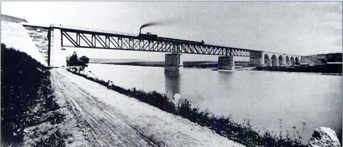
Bild 123: Ein Bauzug befährt die Mariaorter Donaubrücke bei Regensburg an der neuen Strecke nach Nürnberg (über Neumarkt). Pfeiler, Brückenköpfe und die gemauerten Bögen der Flutbrücke sind für zwei Gleise hergerichtet, die Stahlträger hingegen tragen nur ein Gleis. Foto: Sammlung Asmus
