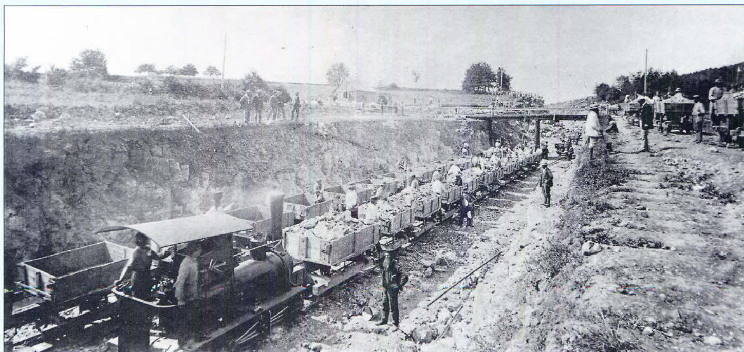
Bild 145: Eine Baulok und zahllose Hände sind am 23. August 1871 bei Parsberg/Laaber damit beschäftigt, die Direktverbindung Regensburg – Nürnberg herzustellen. Für den Fotografen wird eine kleine Pause eingelegt. Fotos 144 bis 149: Sammlung Asmus
